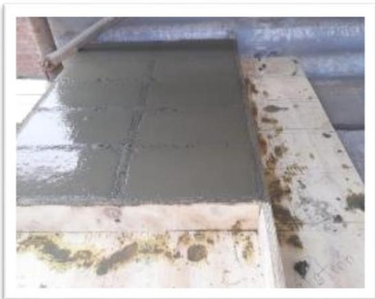
Imagen vaciado y vibrado del adoquín
