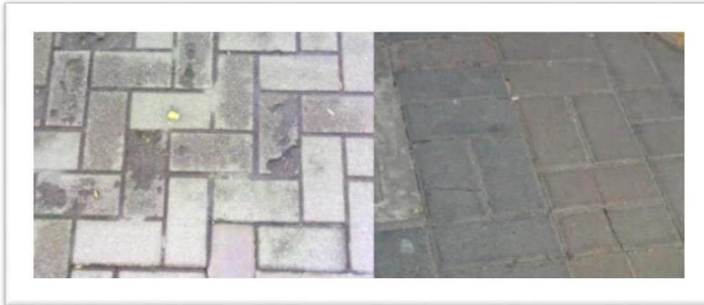
Figura 1: Adoquines de concreto con adición de cenizas volantes
