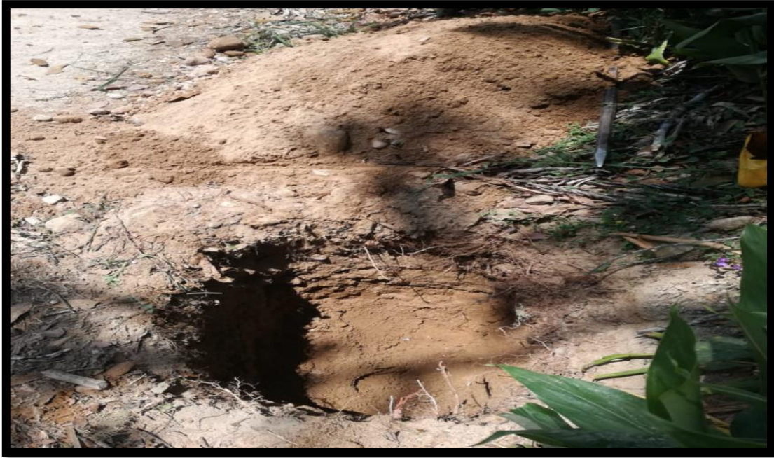
Figura 42. Calicata para la exploración de suelos
