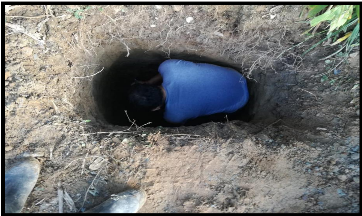
Figura 43. Excavación de calicata
