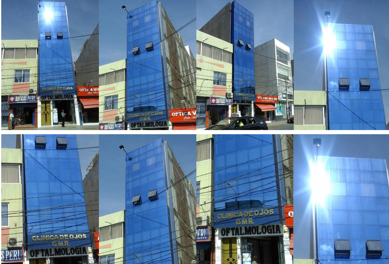
Edificio en la calle Luis Gonzales, cuadra 6
