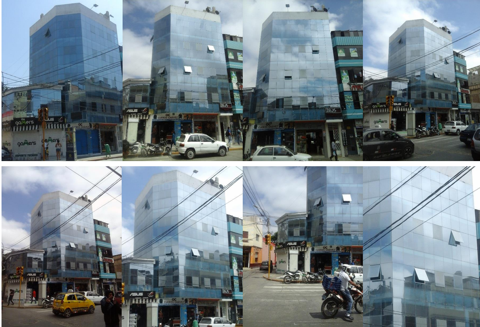
Edificio en la calle San José, cuadra 5
