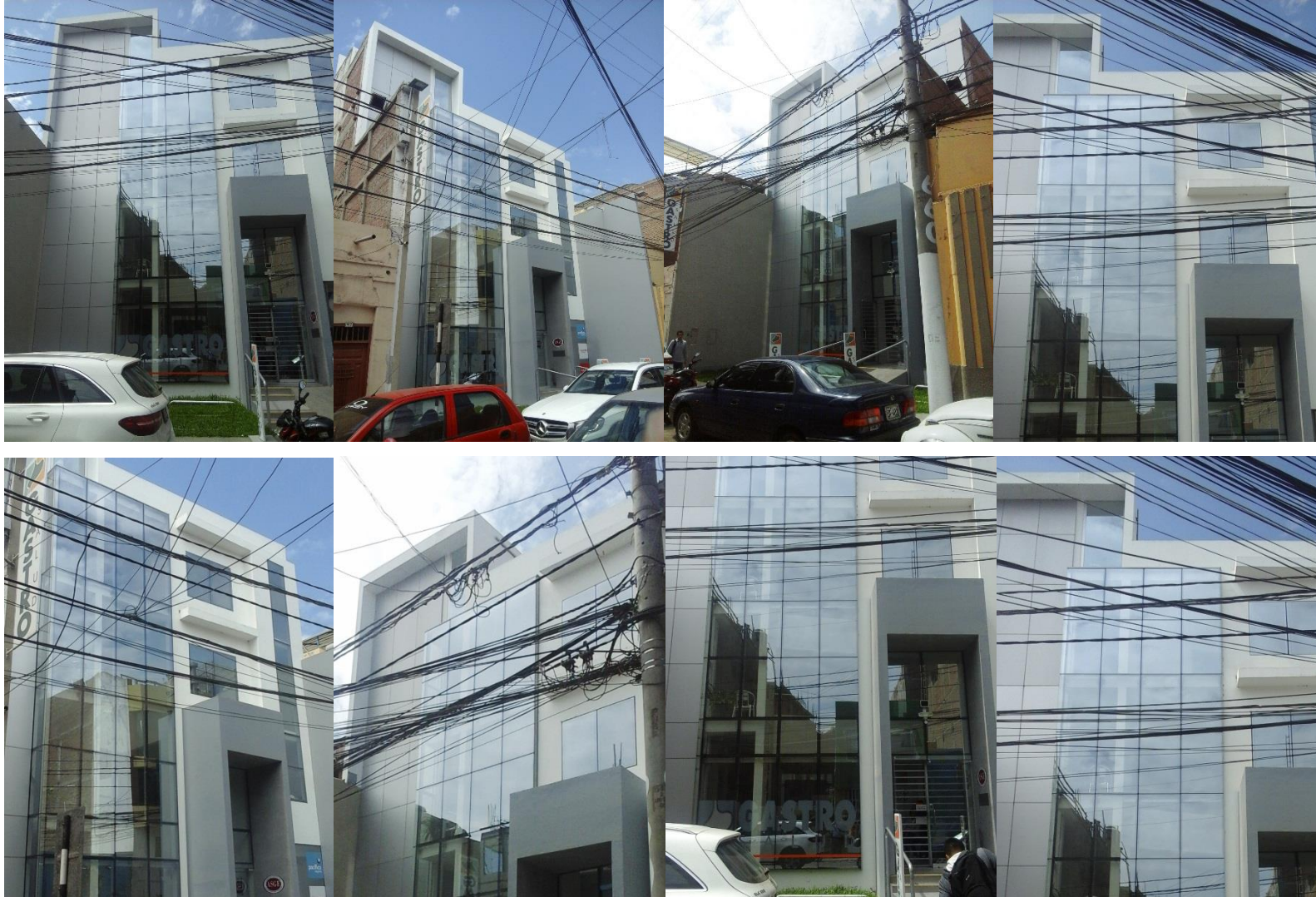
Edificio en la calle Alfonso Ugarte, cuadra 6
