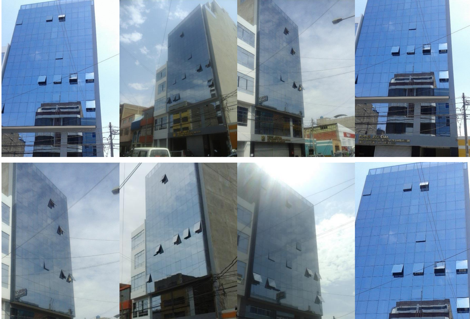
Edificio en la calle Luis Gonzales, cuadra 9
