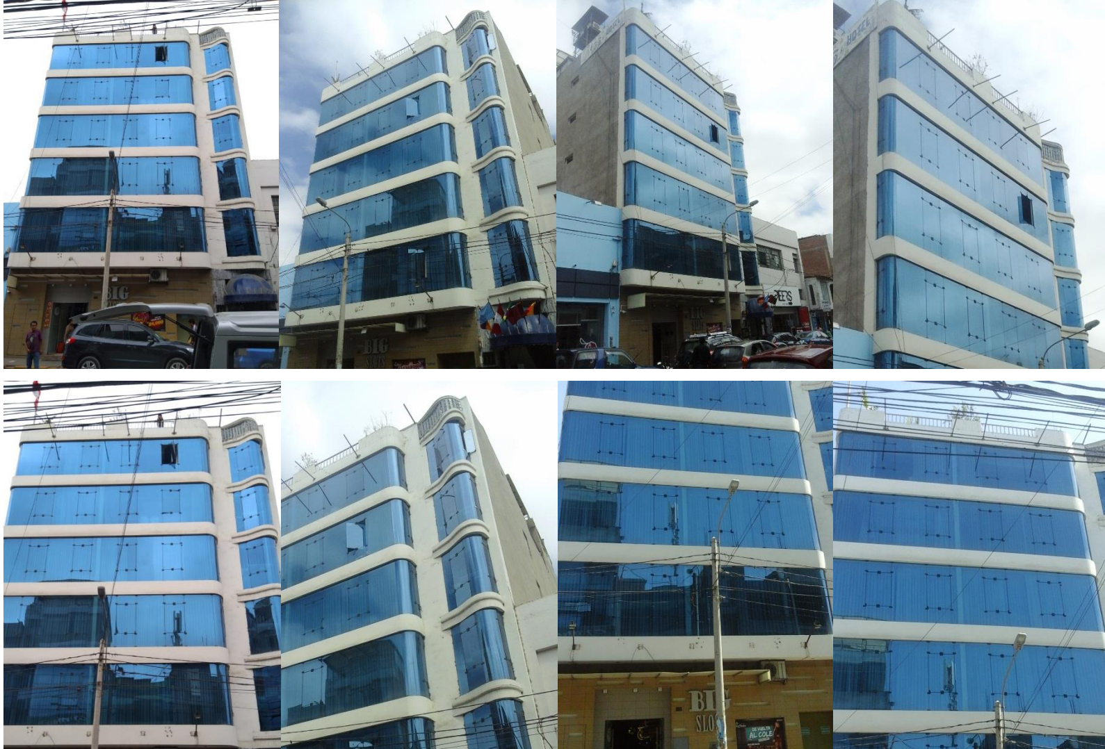
Edificio en la calle San José, cuadra 5
