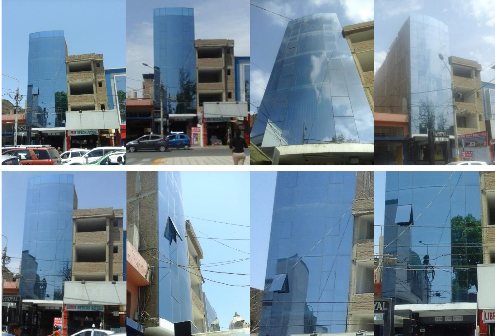
Edificio en la calle San José, cuadra 3
