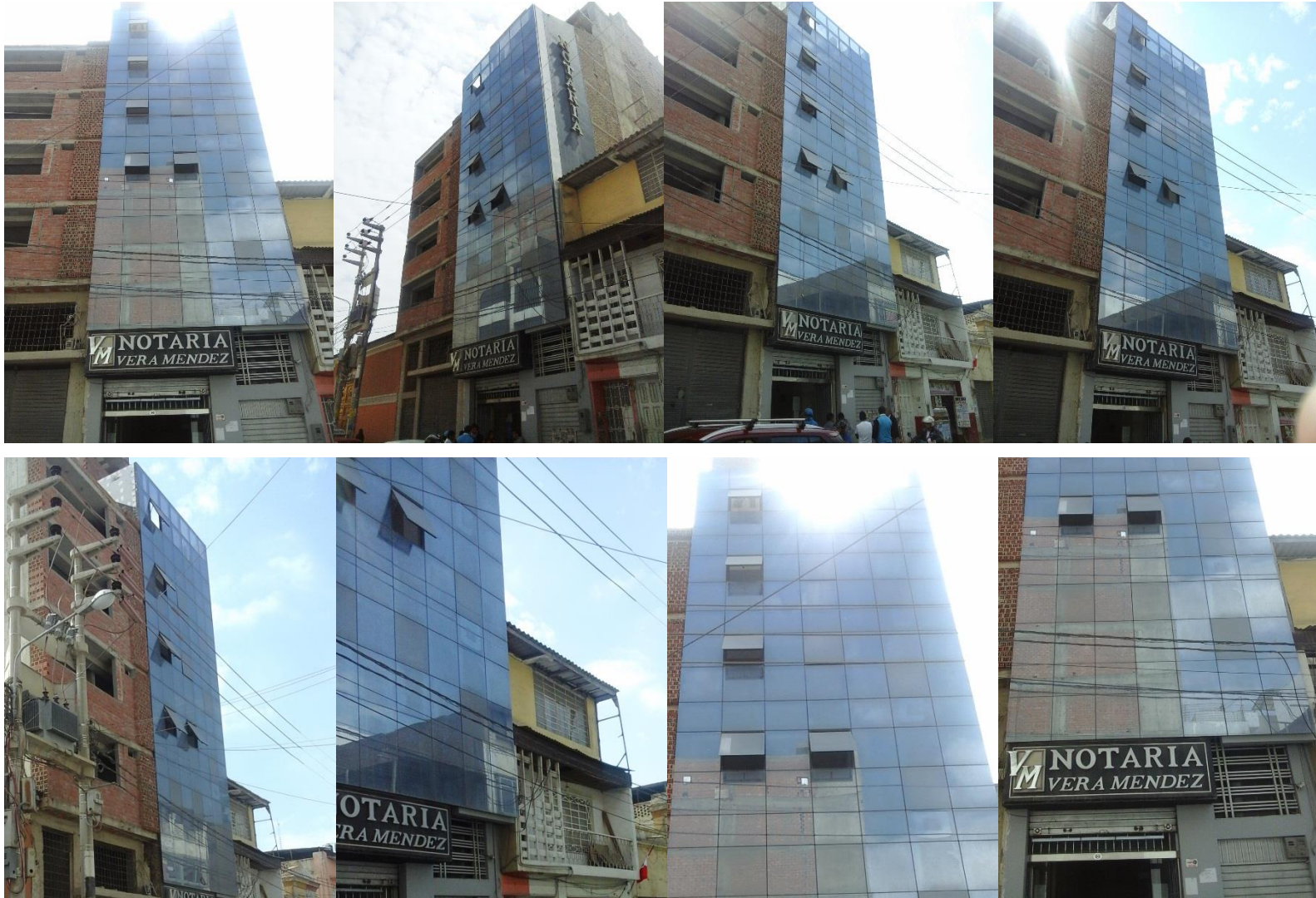
Edificio en la calle San José, cuadra 9
