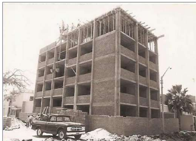
Figura 62: Cerramientos con tabiquería del sistema Aporticado
