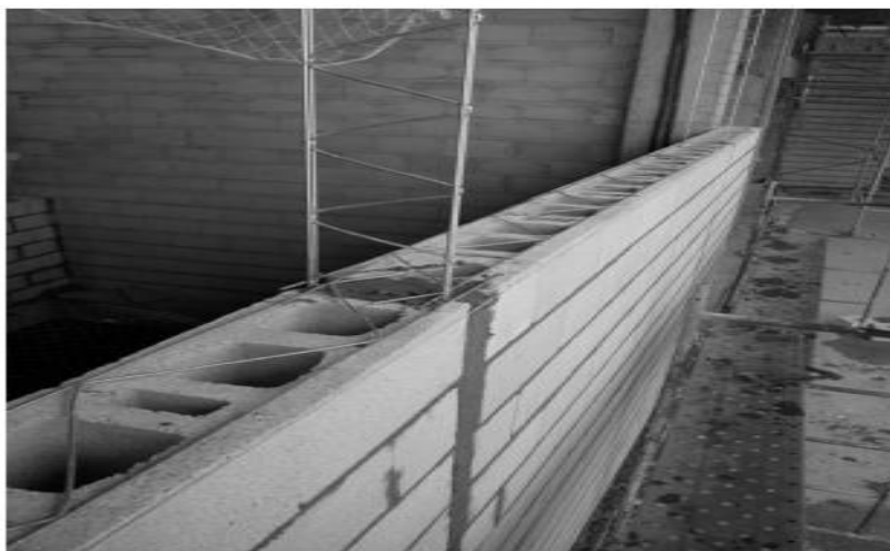
Figura 10. Muro de albañilería armada. Fuente: Youtube.
