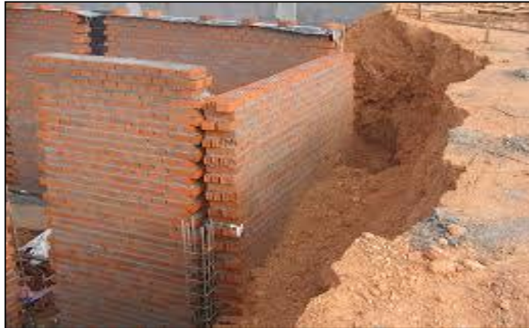
Figura 11. Muro de albañilería confinada. Fuente: Youtube.
