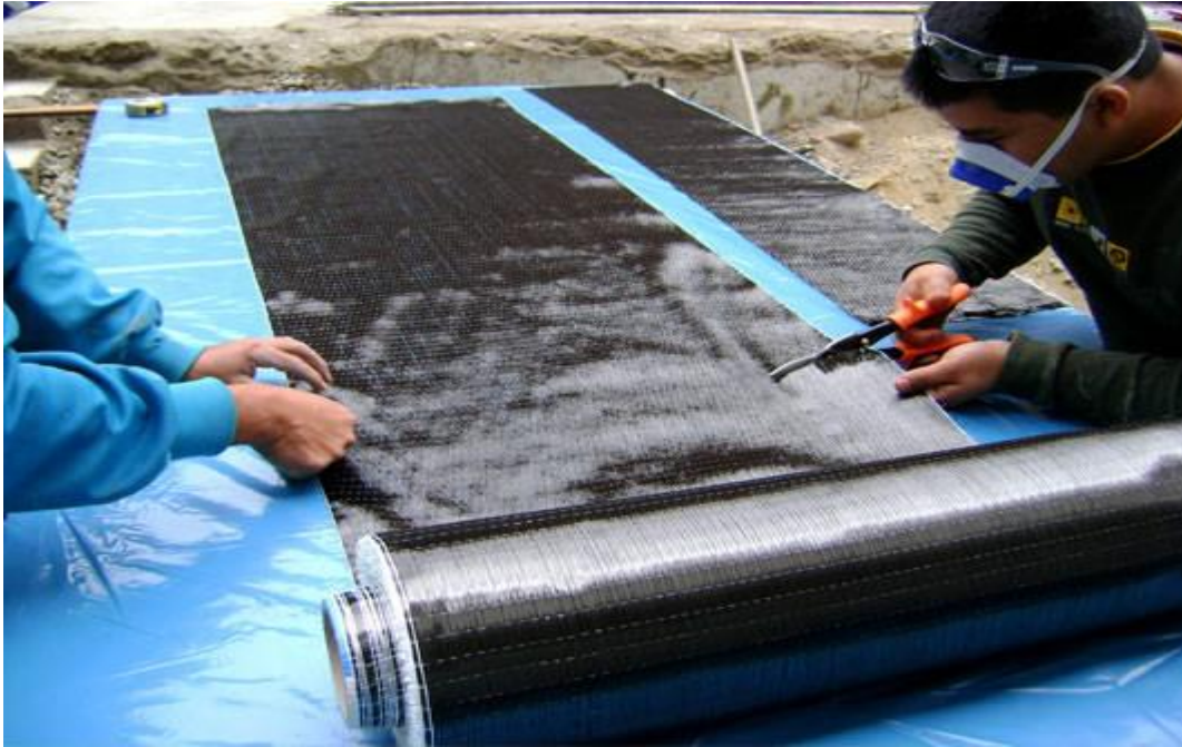
Figura 8. Acondicionamiento de láminas de fibra de carbono. Fuente: Youtube.
