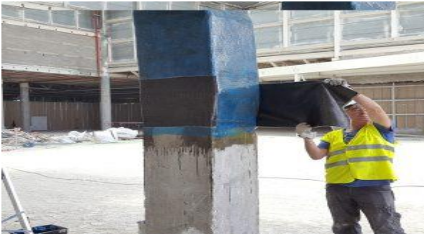
Figura 5. Reforzamiento estructural especial con láminas de fibra de carbono. Fuente: Youtube.
