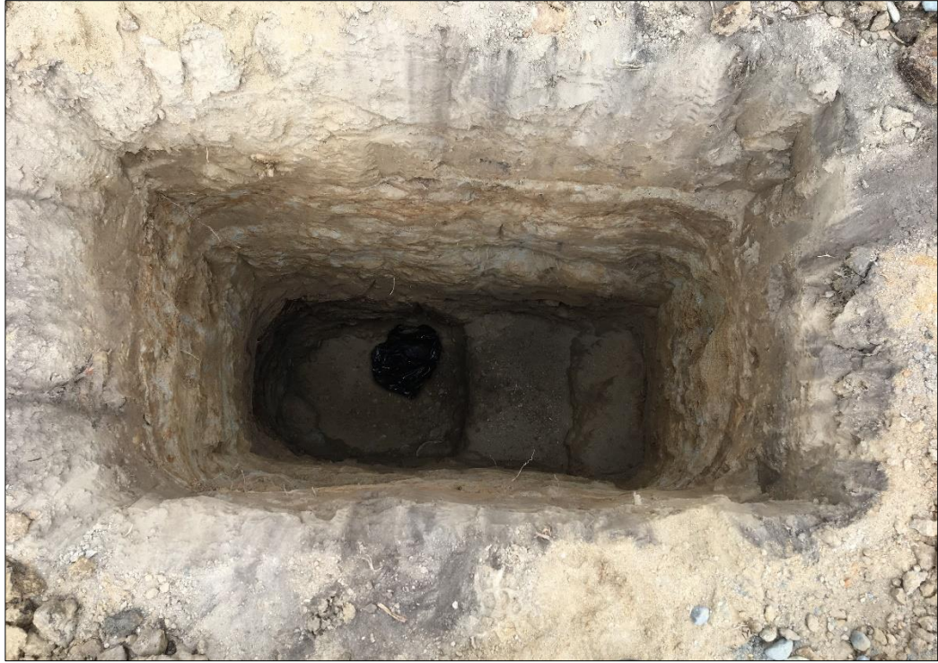
Foto 3. Excavación de calicata. Fuente Propia
