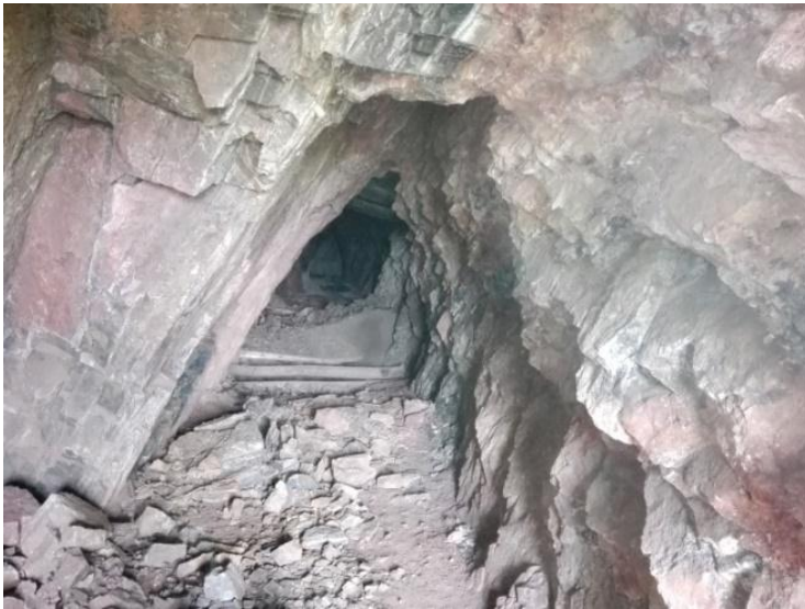
Figura 2. Condiciones de sostenimiento en la mina "Santa Clotilde 7"
