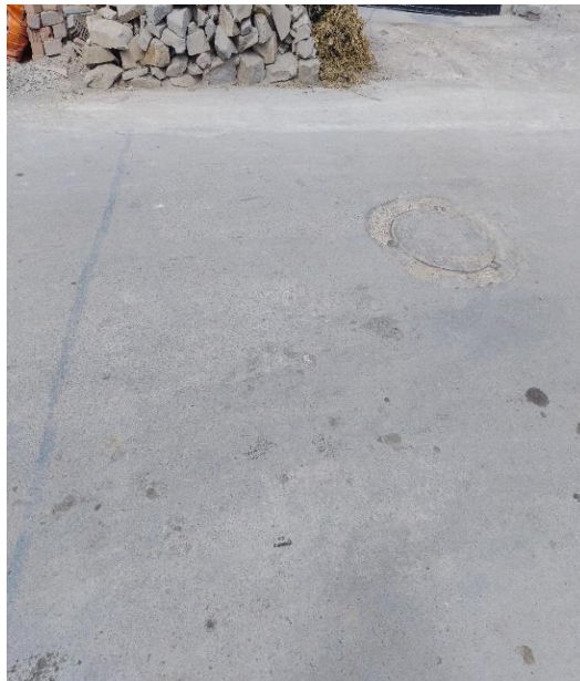
Figura 4 Calle 6 de Ventanilla Alta
