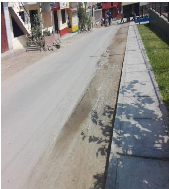
Figura 5 Calle 7 de Ventanilla Alta
