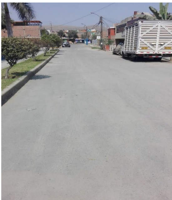
Figura 7 Calle 6 de Ventanilla Alta
