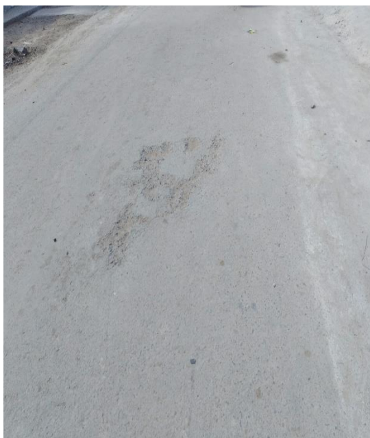
Figura 6 Calle 7 de Ventanilla Alta
