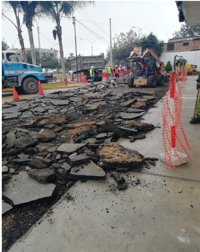
Imagen: Demolición de pavimento envejecido con maquinaria
