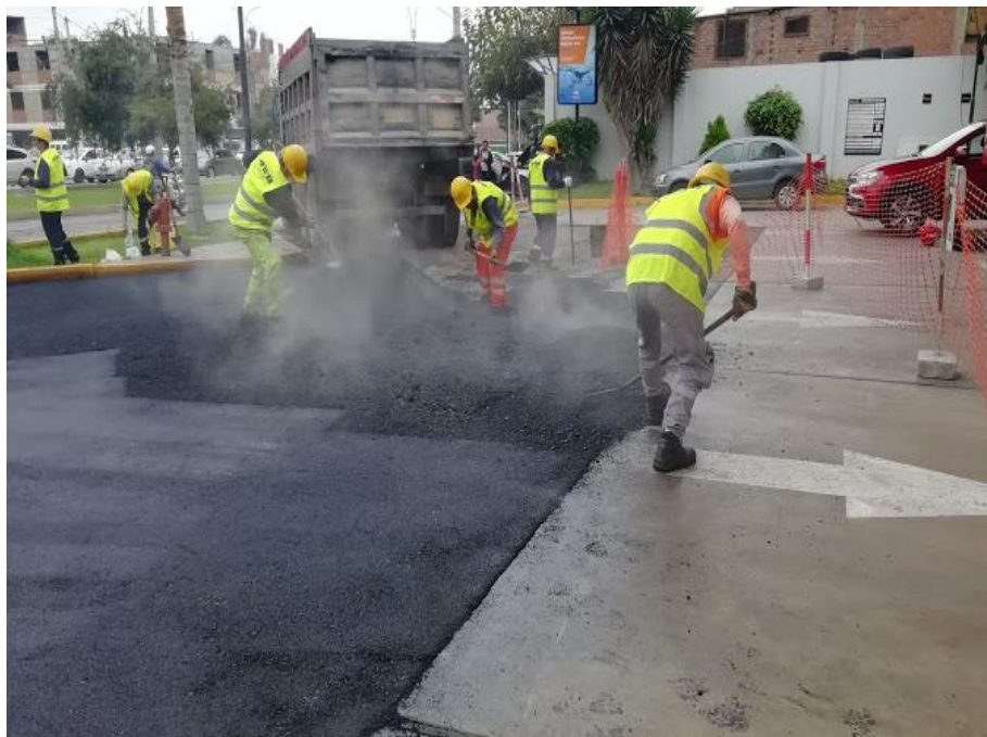
Figura 10 Asfalto traído de planta
