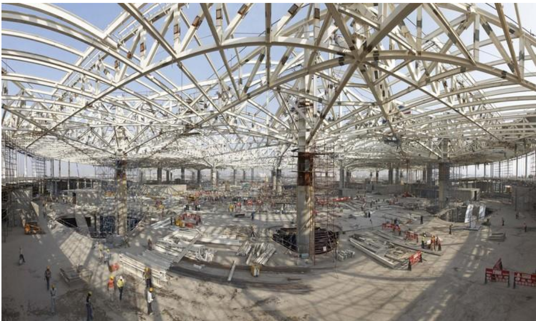
Ilustración 1: Proceso constructivo de la cubierta de la Terminal de aeropuerto Chhatrapati
