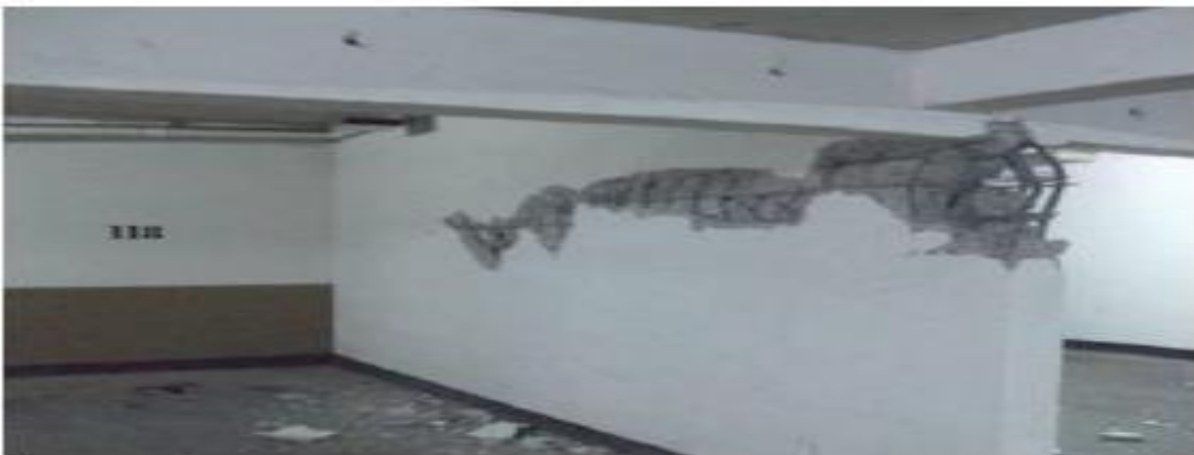
Figura 2: Falla sísmico en sistemas duales.
