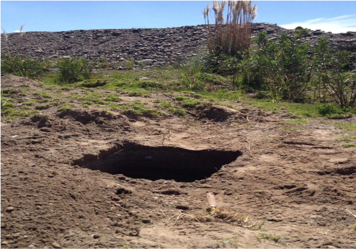
Imagen de la calicata.
