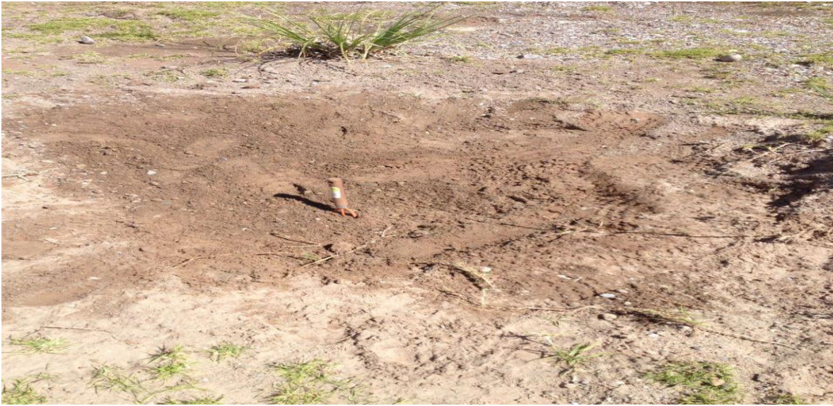
Imagen del llenado de la calicata.
