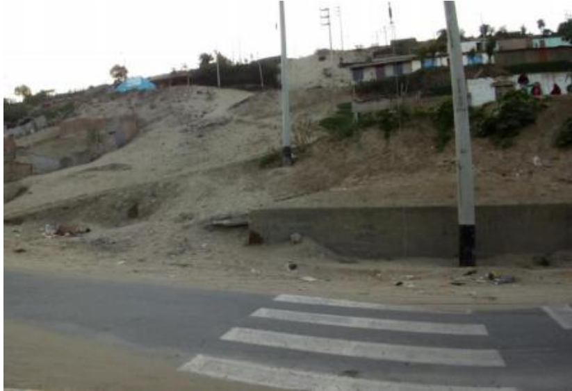
Figura 1: Muro de contención- Asentamiento Humano Bellavista Independencia
