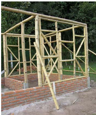
Figura 115. Estructura de bambú Fuente: Arte y bambú
