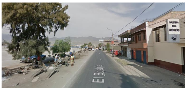
Figura 145. Vista de la Av. Del Bosque
