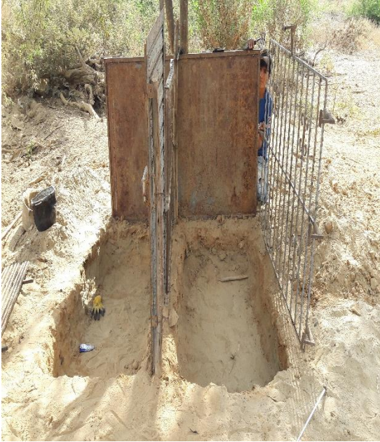
Fotografía N°1: Construcción de camas muestra de suelo
