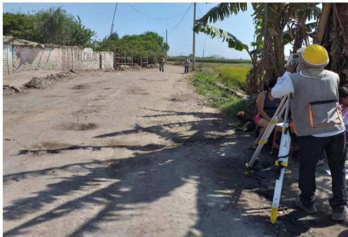
IMAGEN 06: Toma de puntos de eje de la red vial vecinal con la estación total.
