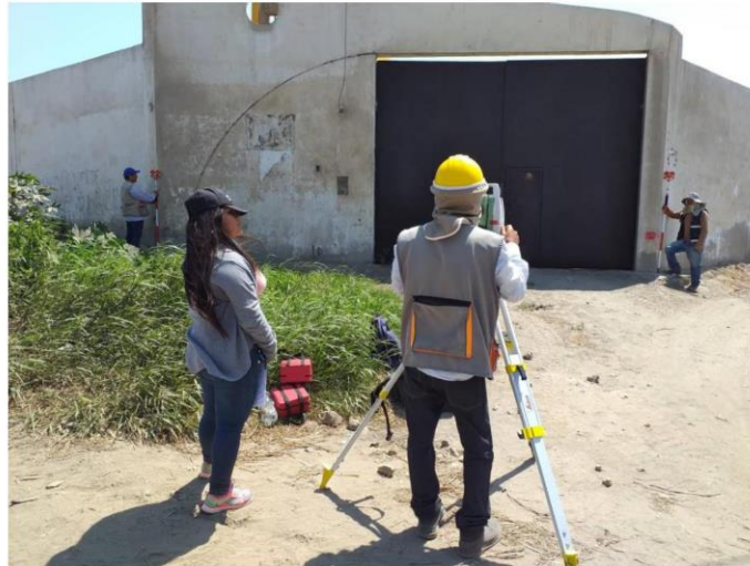
IMAGEN 03: Toma de puntos de linderos de la red vial AN-876 con estación Total Leica.
