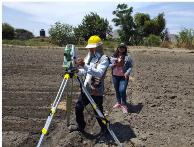
IMAGEN 10: Toma de puntos de estación red vial vecinal con la estación total.
