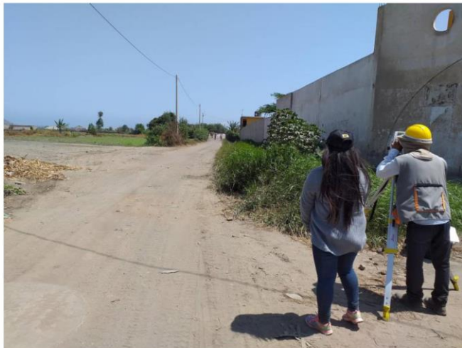
IMAGEN 08: Toma de puntos de terreno red vial vecinal con la estación total.
