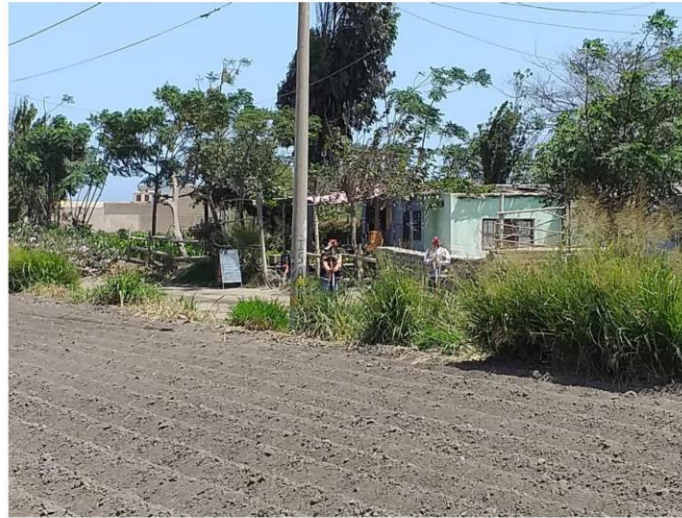
IMAGEN 11: Toma de puntos de viviendas red vial vecinal con la estación total.
