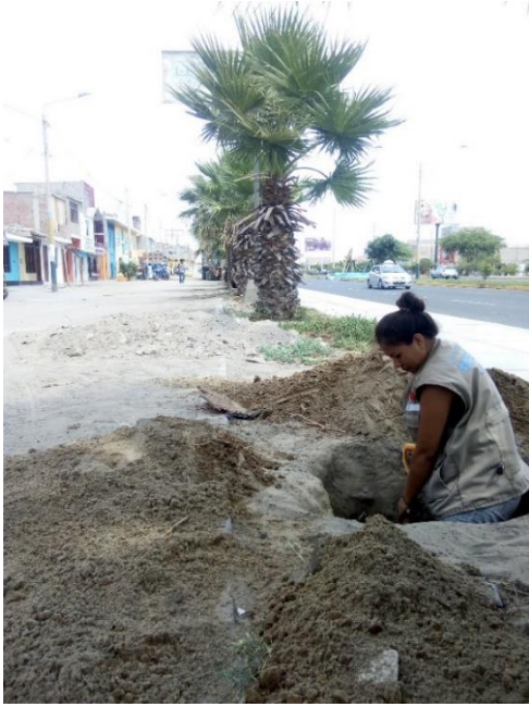
FOTOGRAFÍA 5: CALICATA N°1 DE LA AVENIDA PACÍFICO, TRAMO: EL CRUCE P.PAO - AV PORTUARIA
