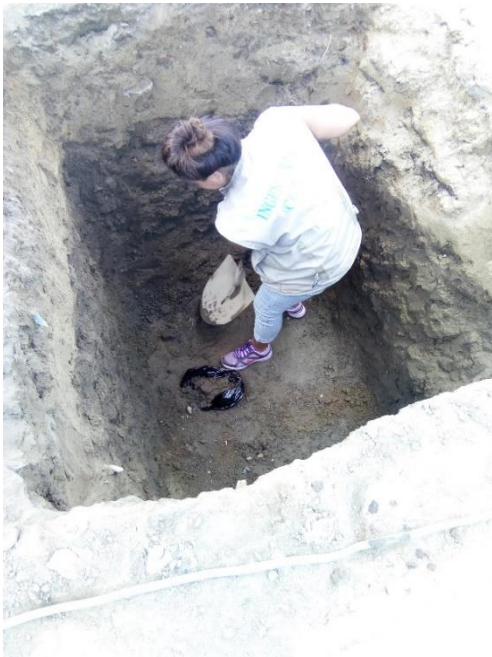
FOTOGRAFÍA 7: CALICATA N°3 DE LA AVENIDA PACÍFICO, TRAMO: EL CRUCE P.PAO - AV.PORTUARIA
