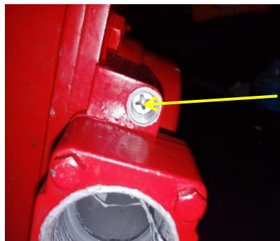
Figura 30. Ajuste interno del medidor
