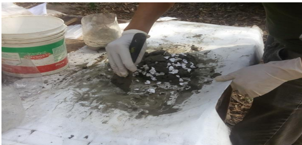
Figura 8. Mezcla de materiales
