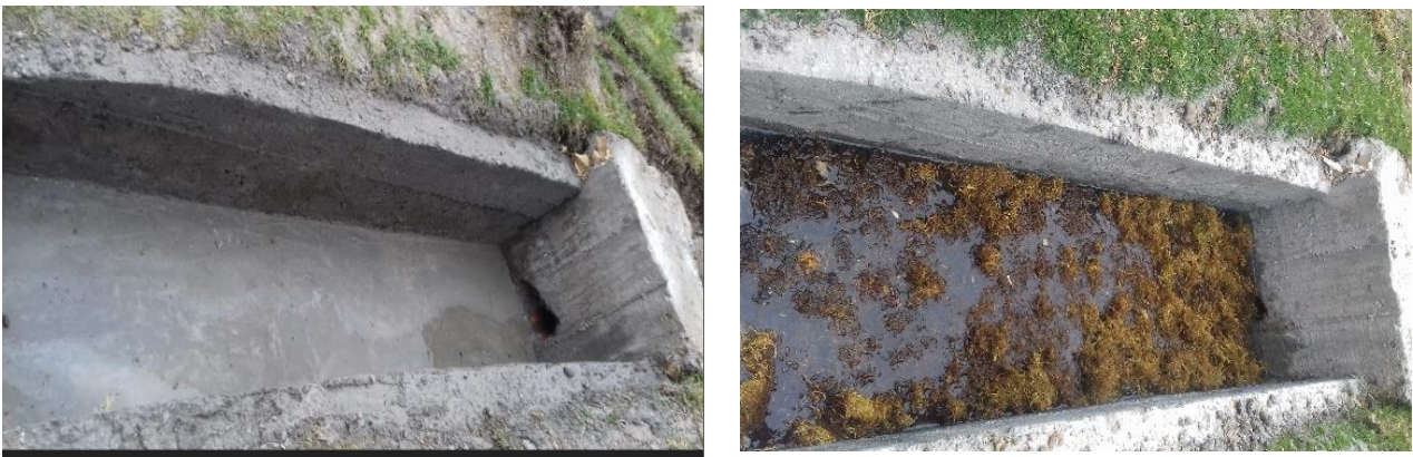
Figura. 10 Construcción del biofiltro Fuente: Elaboración propia
