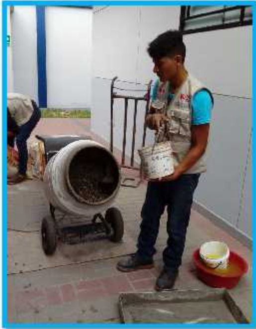
Abastecimiento a la maquina mezcladora de concreto.
