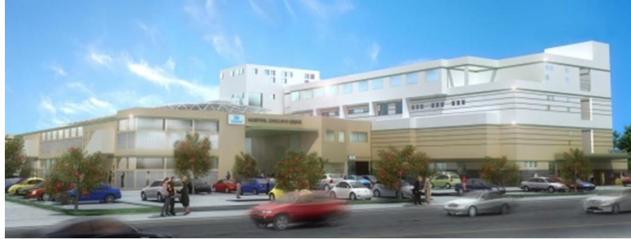
Figura 13: Hospital de Chiclayo oeste
