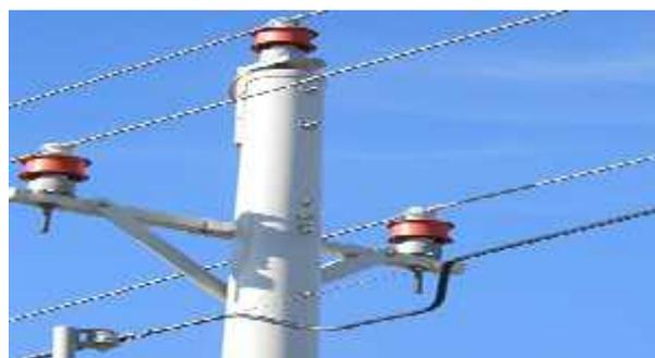
Figura N° 12.- Postes Poliéster Reforzado con Fibra de Vidrio, para baja y media tensión
