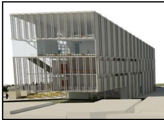
Figura 11: Fachada Principal Bloque Biblioteca
