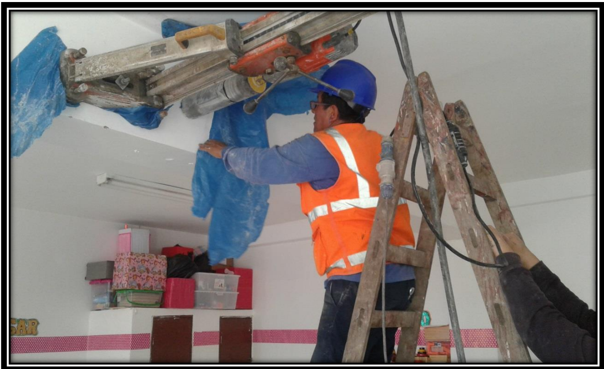
Figura 20: Extracción de testigos de la viga N° 1
