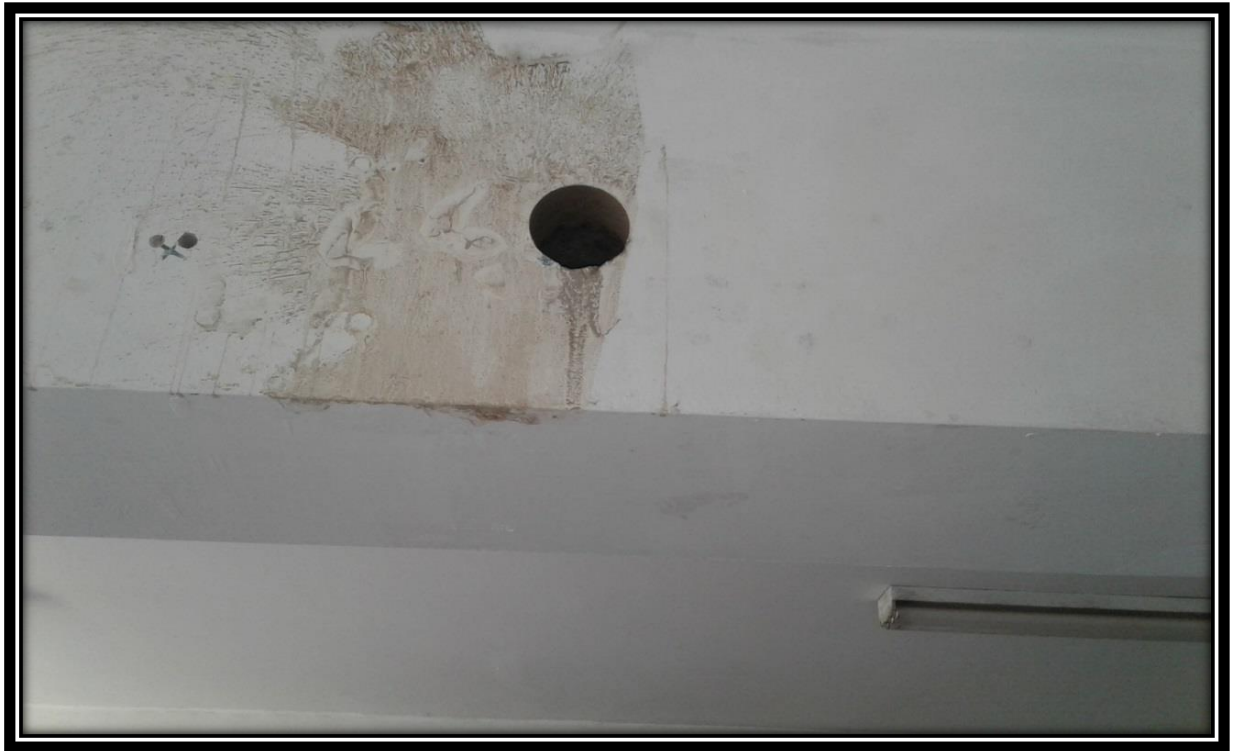
Figura 21: Extracción de testigos de la viga N° 2
