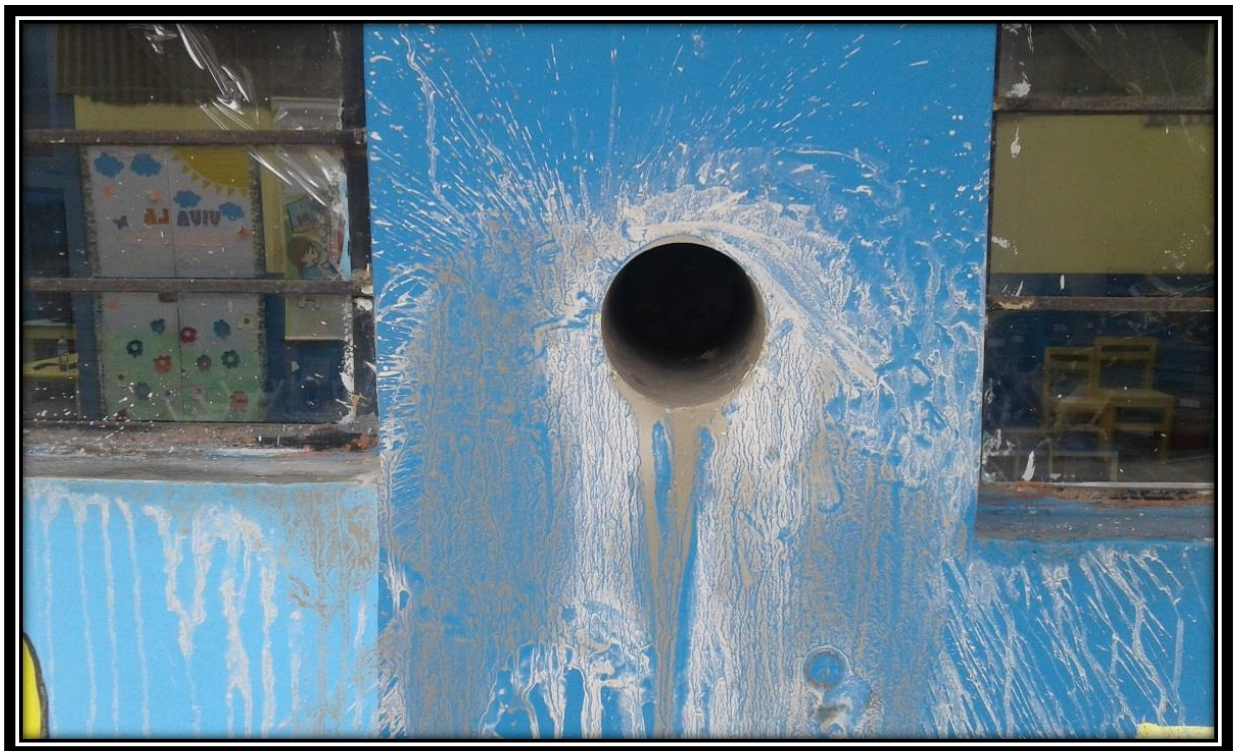
Figura 22: Extracción de testigos de la columna N° 2
