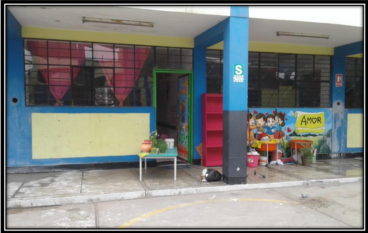
Figura 23: Columnas centrales donde se realizó la extracción de testigos.
