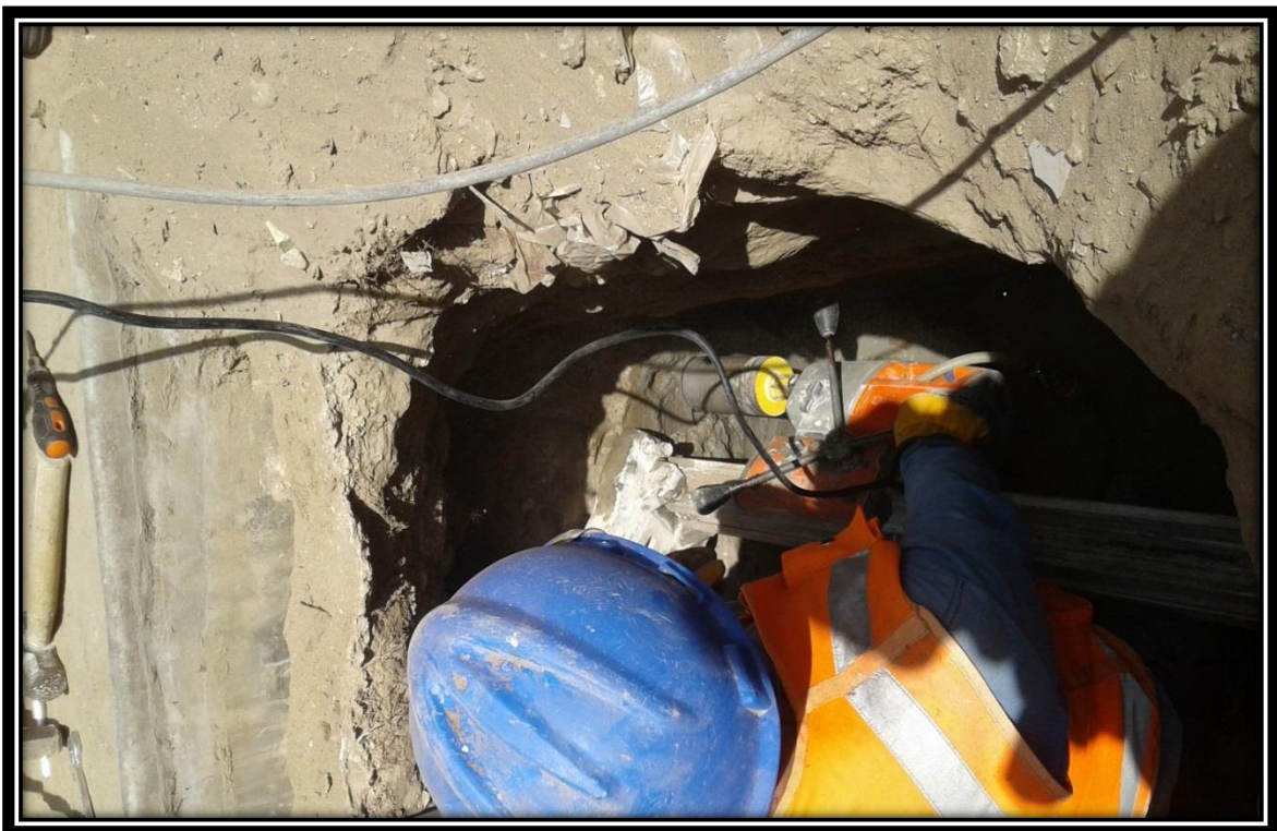
Figura 24: Extracción de testigo en la cimentación.
