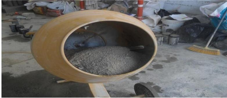
*Figura 64.* Colocación del agregado fino y del cemento a la mezcladora. Fuente: Propia
