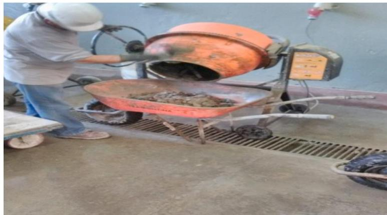
Figura 45: Colocación de la mezcla en la carretilla. Fuente Propia
