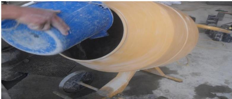
*Figura 65.* Adición del agua a la mezcla. Fuente: Propia.
