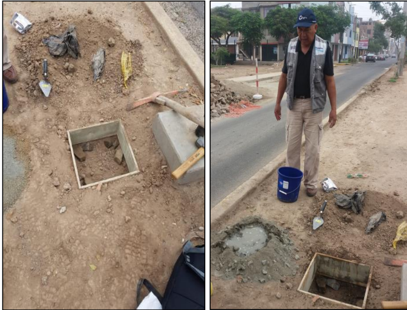
Figura 8. Colocación de molde y preparado de mezcla para hito de concreto.
