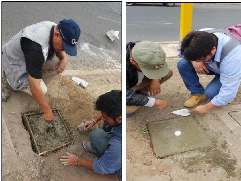
Figura 14. Llenado de mezcla y colocación de placa de bronce en hito de concreto.
