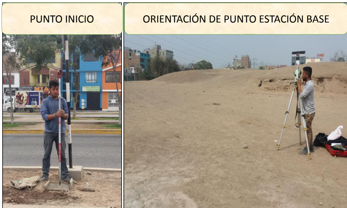
Figura 18. Levantamiento topográfico del área del proyecto.
