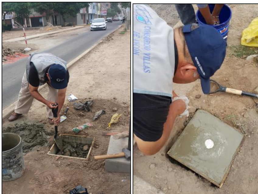
Figura 9. Llenado de mezcla y colocación de placa de bronce en hito de concreto.
