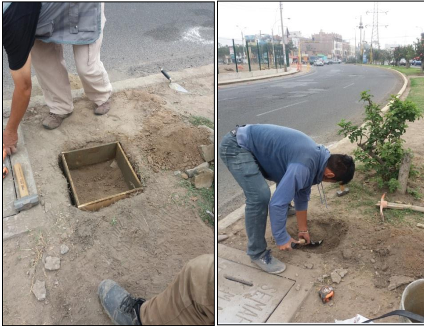
Figura 13. Colocación de molde y preparado de mezcla para hito de concreto.
