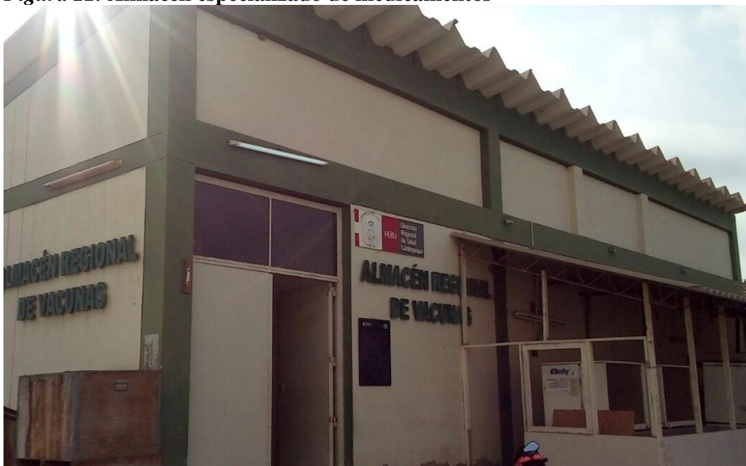
Figura 22. Almacén especializado de medicamentos
