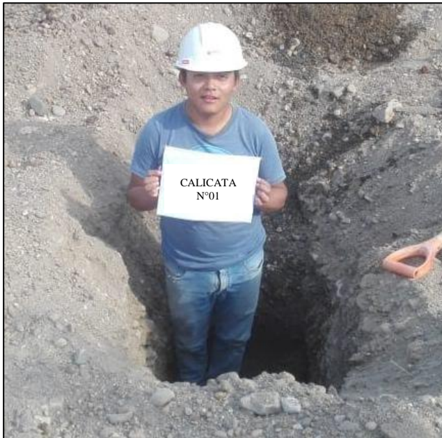
Figura 7: Excavación de la Calicata N°01.
