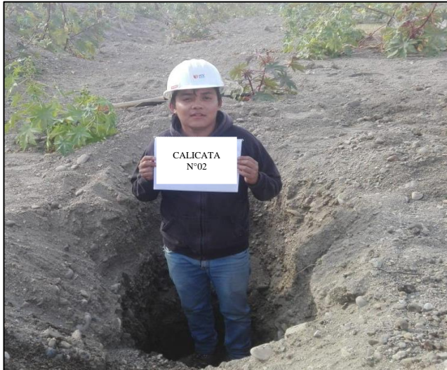
Figura 8: Excavación de la Calicata N°02. Fuente: Elaboración propia.
