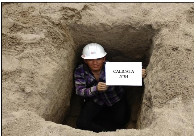
Figura 10: Excavación de la Calicata N°04. Fuente: Elaboración propia.
