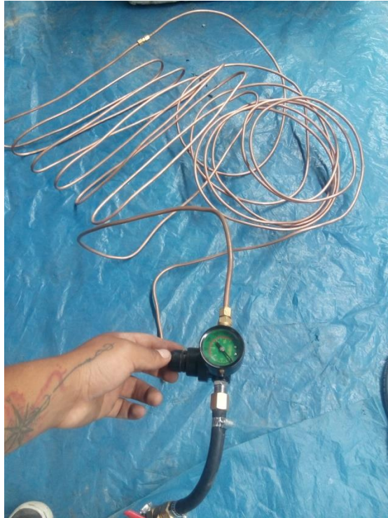
Figura 14: Ensamble de la tubería de cobre Fuente: elaboración propia, 2018
