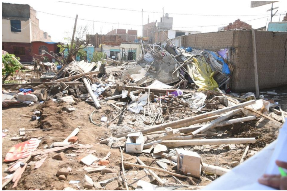
Figura 11: Derrumbe total de viviendas por huayco
