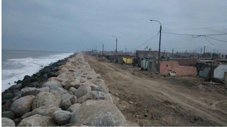
Figura 21: Muro de piedra contra el oleaje anómalo y erosión costera
