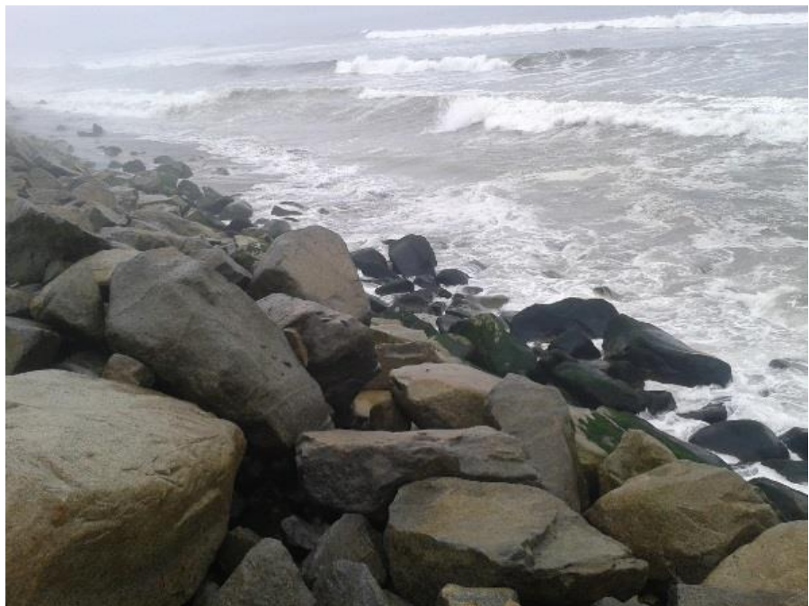
Figura 18: Playa de Buenos Aires, Trujillo, amurallada con piedras para mitigar erosión en el 2015.
