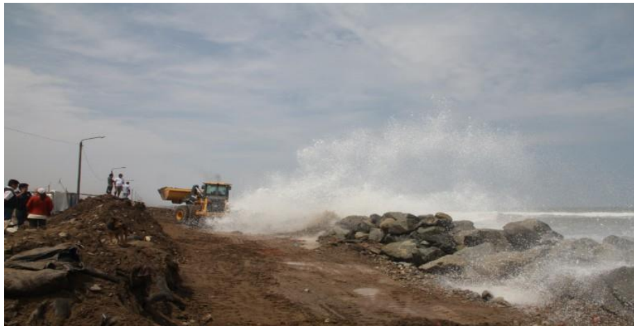
Figura 22: Trabajos de empedrado de la playa Buenos Aires contra el oleaje anómalo y la erosión costera
