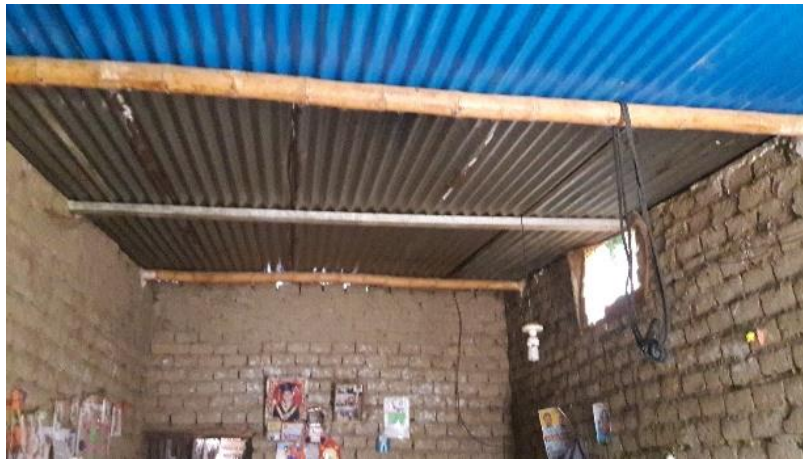
Figura 36: Sistema constructivo – toma fotográfica de las condiciones de la vivienda
