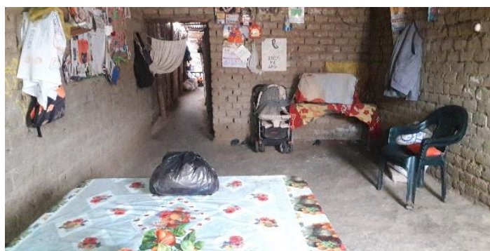
Figura 38: sistema constructivo –condiciones de los elementos y las unidades
