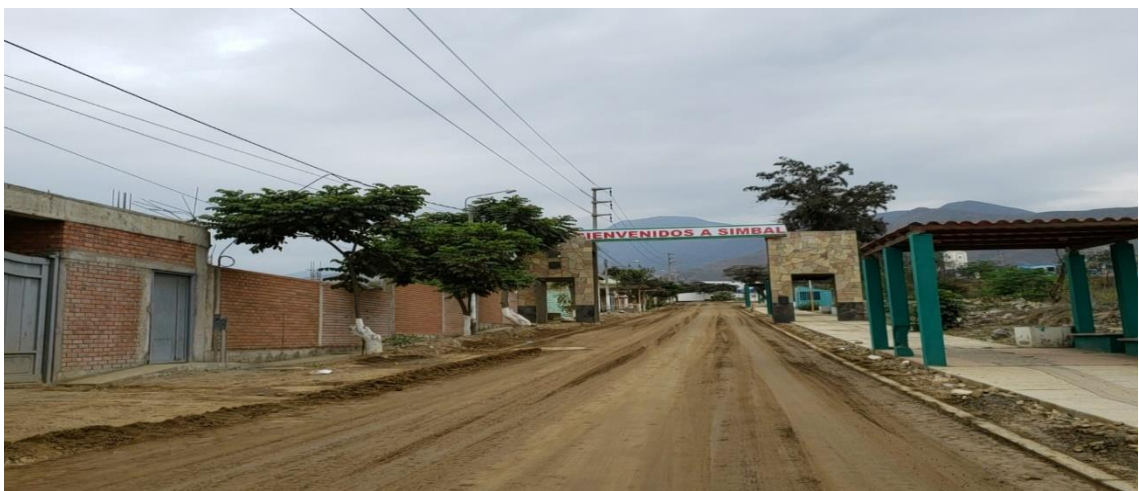
Foto 28: Reconstrucción del asfalto en Simbal
