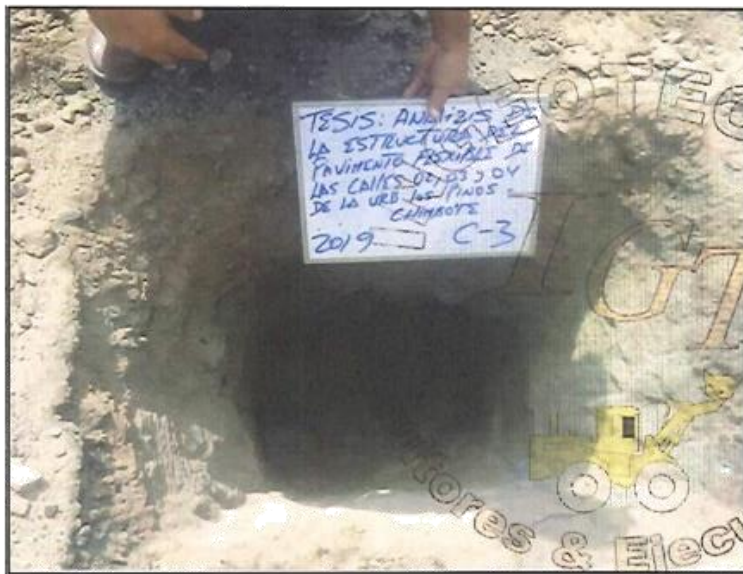
FOTO 05: SE OBSERVA LA EXCAVACIÓN CALICATA C-03.
