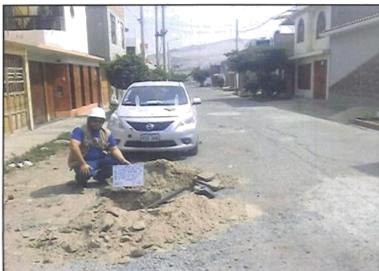
FOTOS 02: SE OBSERVA UNA VISTA PANORÁMICA DE LA EXCAVACION DE LA CALICATA C-01.
