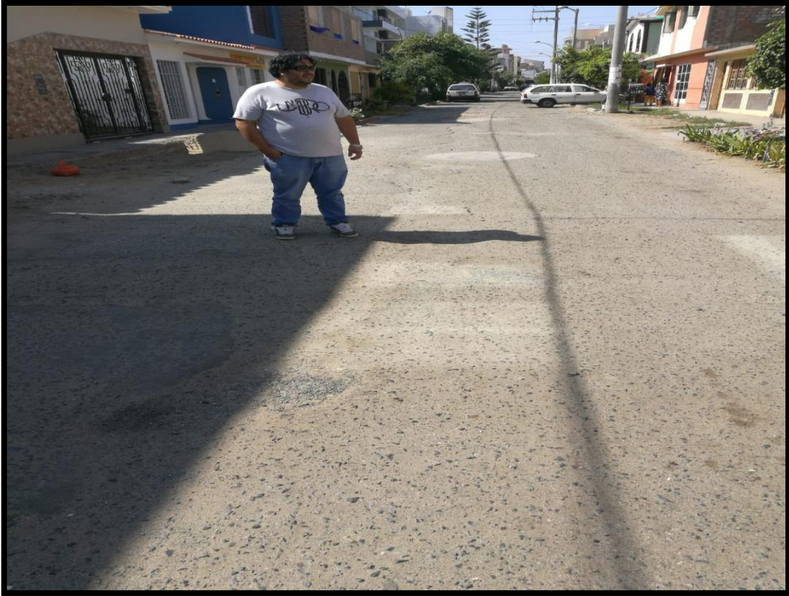
Carpeta asfáltica deteriorada
