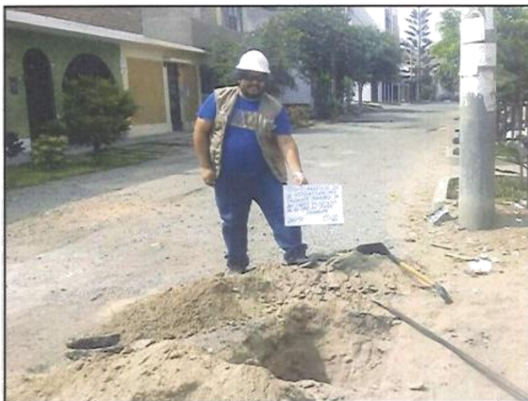
FOTOS 04: SE OBSERVA UNA VISTA PANORÁMICA DE LA EXCAVACION DE LA CALICATA C-02.
