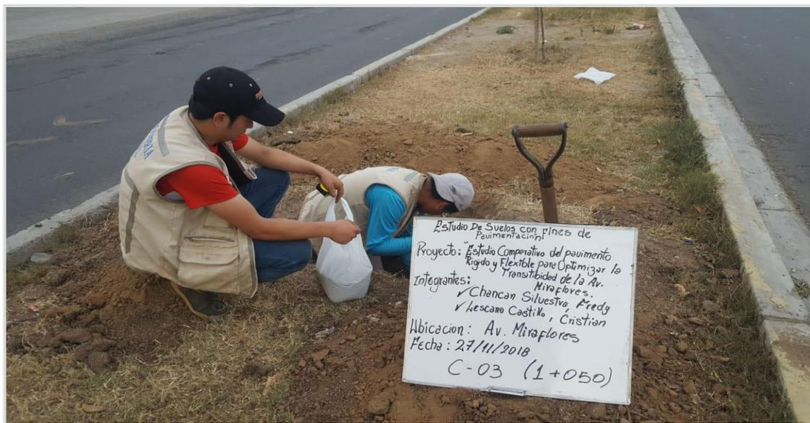
**Figura 80.** Extracción de estratos en la calicata 03.
