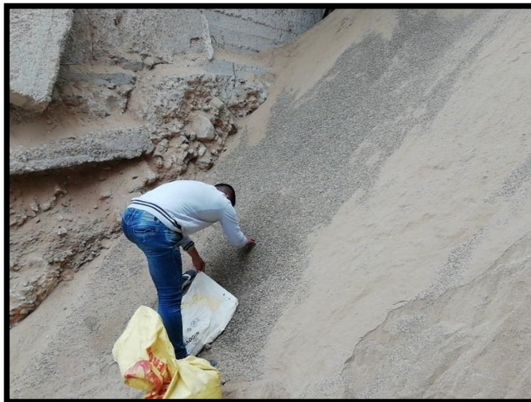
Figura 31. Extracción de agregado fino.
