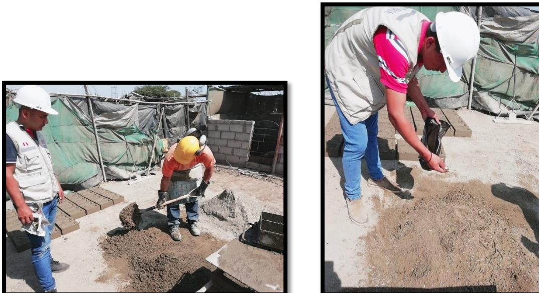
Figura 33. Preparación de la mezcla de concreto para la elaboración de los ladrillos.
