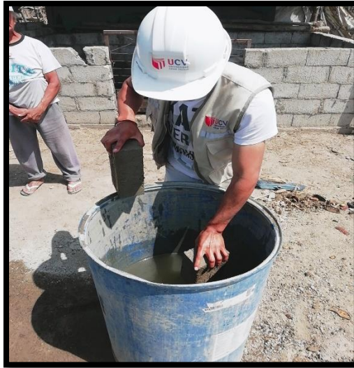
Figura 40. Curado en latones de agua, al día próximo de la elaboración.
