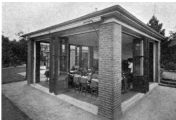
Imagen N|°9. Aulas con apertura al exterior.
