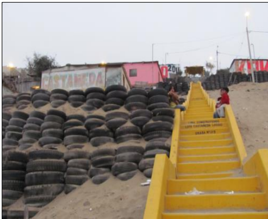
Figura 2. Muro de contención con neumáticos en el AA.HH Lomo de Corvina.
