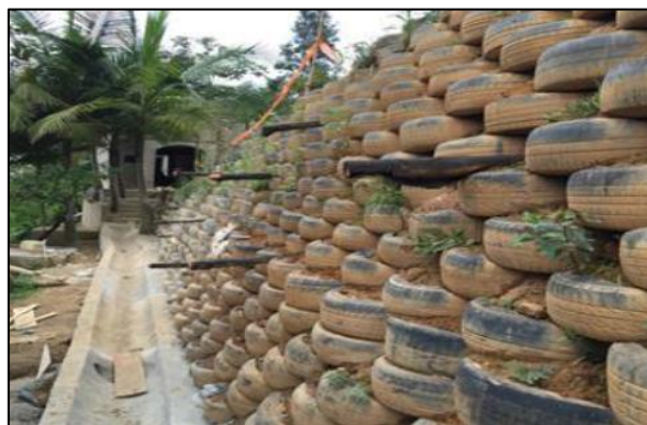
Figura 6. Drenaje con tubos de 2" en muros de contención utilizando neumáticos
