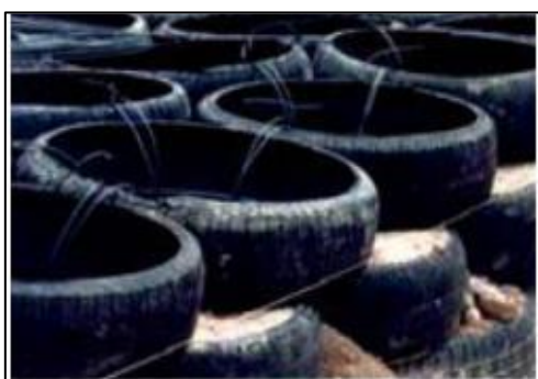
Figura 14. Amarre con acero galvanizado
