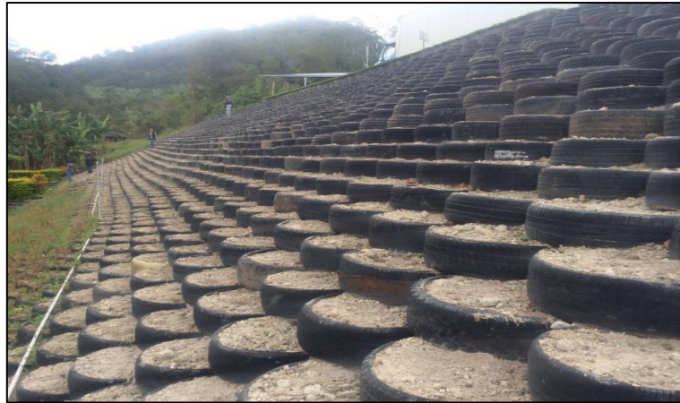
Figura 7. Muro de contención con neumáticos reciclados
