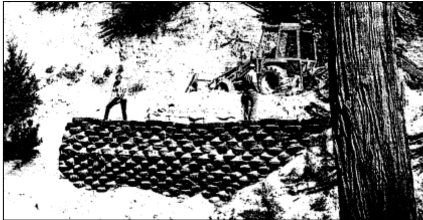
Figura 1 Muro con neumáticos en California
