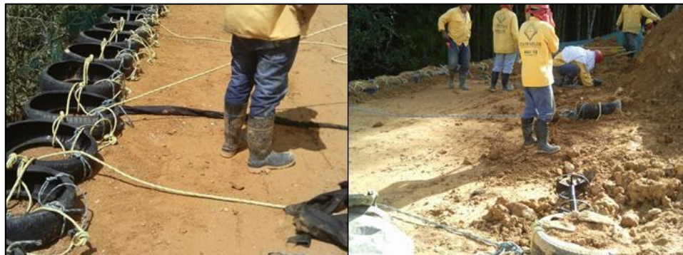
Figura 19. Amarre entre neumáticos y tensores
