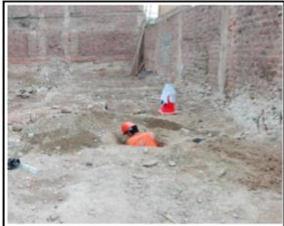
UBICACIÓN DE CALICATA C-2
