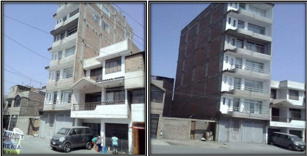
Figura 1. Vivienda de Albañilería Confinada.
