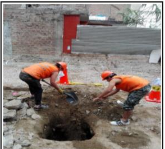
RESANE DE CALICATA C-3
