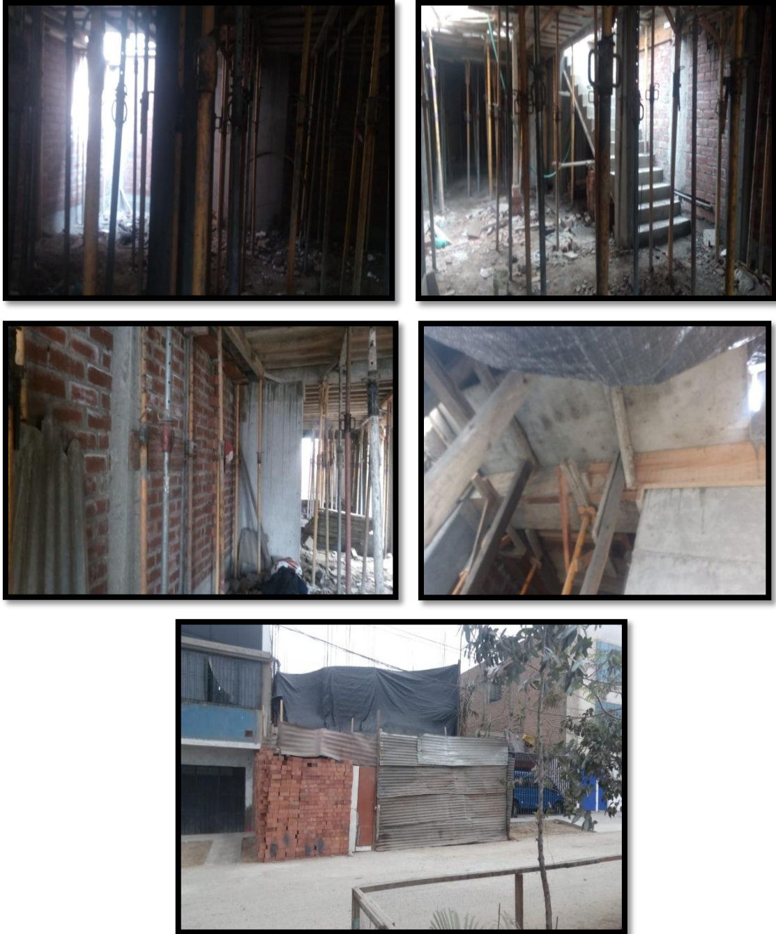
Figura 74. Vista Panorámica de cómo está quedando la vivienda.
