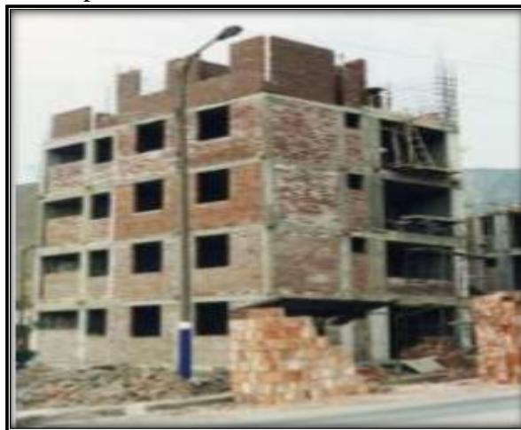
Figura 6. Construcción de una vivienda de albañilería.
