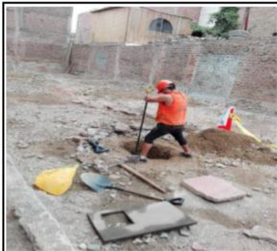
UBICACIÓN DE CALICATA C-3
