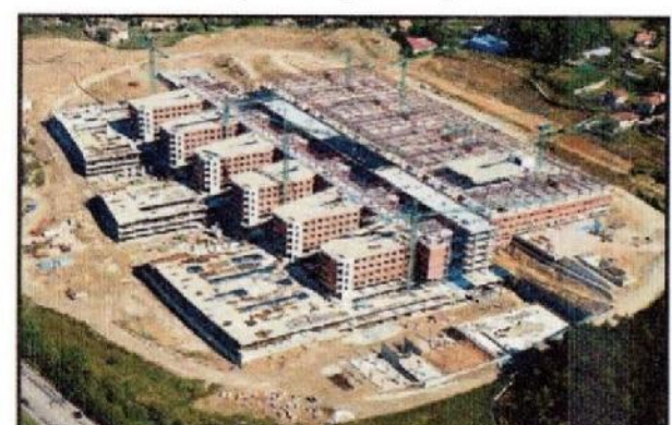
3 Ejecución de los cerramientos de fachada e impermeabilización de cubiertas en el edificio que albergará los quirófanos.
