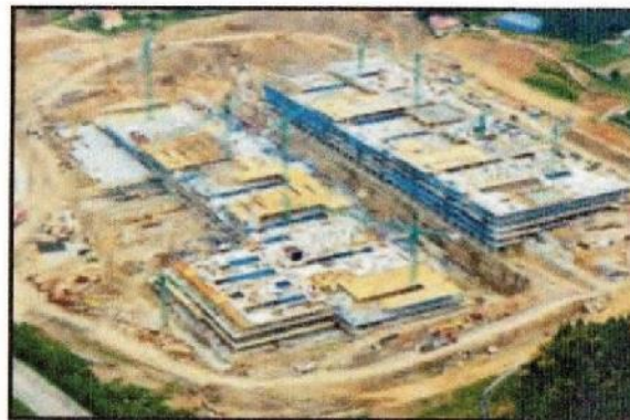
2 Finalizada la estructura se inicia la construcción de envolventes y del viaducto que une el exterior con los viales internos.
