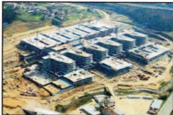
4 Una vez finalizados los trabajos exteriores, comienza la retirada de las grúas así como la tabicación de interiores.
