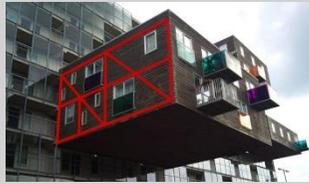
Las paredes medianeras se construyeron ocho centímetros más gruesas de lo necesario desde el punto de vista estructural para mejorar el aislamiento acústico, lo que permitió utilizar este grosor extra para anclar las vigas voladas sin necesidad de aumentar el peso de los muros de carga. Las regulaciones acústicas y contra incendios hicieron necesario el revestimiento de estas cerchas.
