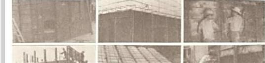
Sistema constructivo de muros techo y cimentación es vaciado e sitio. Encofrados metálicos, especialmente diseñados, para cada uno de los componentes, definen un procedimiento constructivo relativamente simple. El aspecto propio es la formación de modos constructivos o cubos, que integran en una unidad monolítica, una losa de cimentación nervada de reducido espesor una losa nervada e echo, armada e dos direcciones.
