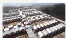
El edificio Villa Verde, utiliza muy eficazmente el uso de la madera. Asimismo, esta estructura es ejecutada por paneles estructurales para la entrega inicial con el fin de que en una futura ampliación se utilice el mismo sistema de paneles. Se emplea a su vez, un montaje de bajada de lluvias que es colocado entre cada vivienda adosada a otra
