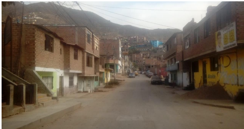
Figura 1: Edificaciones de mampostería confinada Avenida El Trabajo en Independencia Fuente: Elaboración Propia
