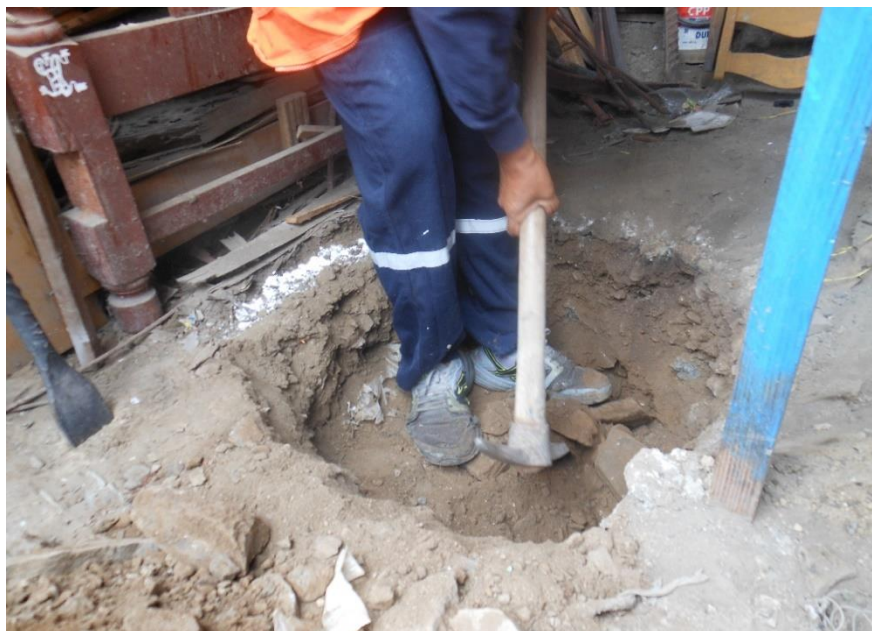
Figura 31: A9.1 - Excavación de la Calicata 1 Fuente: Elaboración Propia
