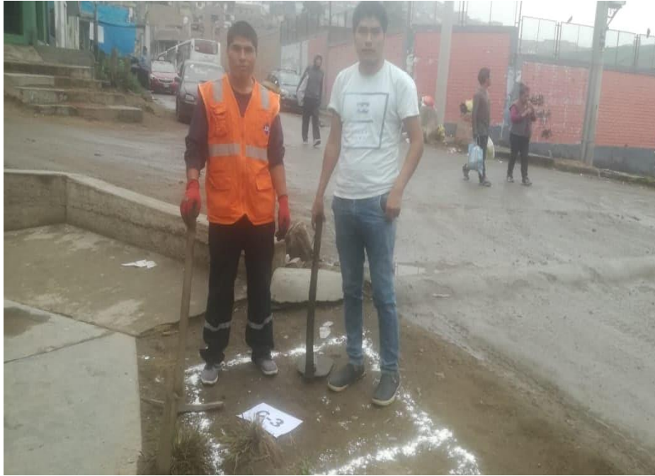
Figura 33: A9.3 - Excavación de la Calicata 3 Fuente: Elaboración Propia
