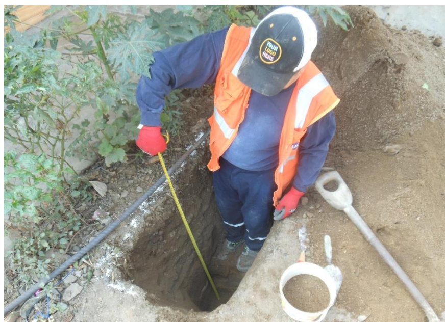
Figura 32: A9.2 - Excavación de la Calicata 2 Fuente: Elaboración Propia
