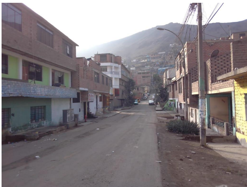
Figura 17: Viviendas de Albañilería confinada (Av. El trabajo) Fuente: Elaboración propia.
