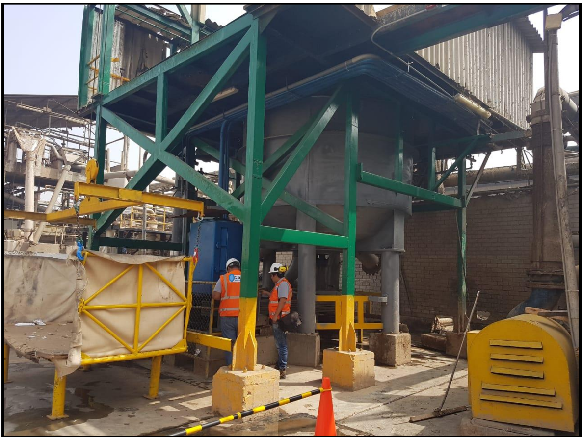
Gráfico 27: Análisis termo grafico a la estación del tanque de agua zona 3
