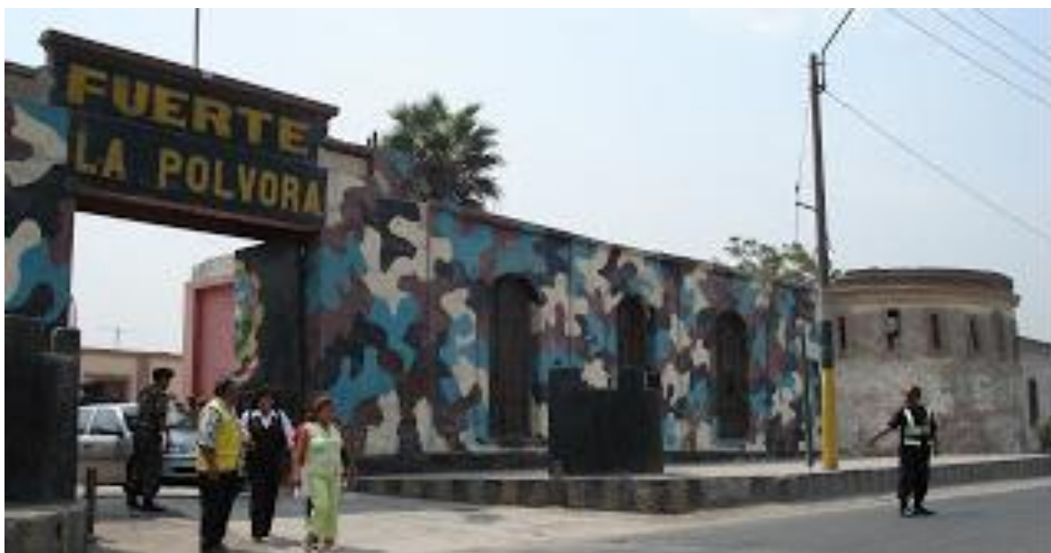
Figura 5. Fachada Antigua del Fuerte La Pólvara
