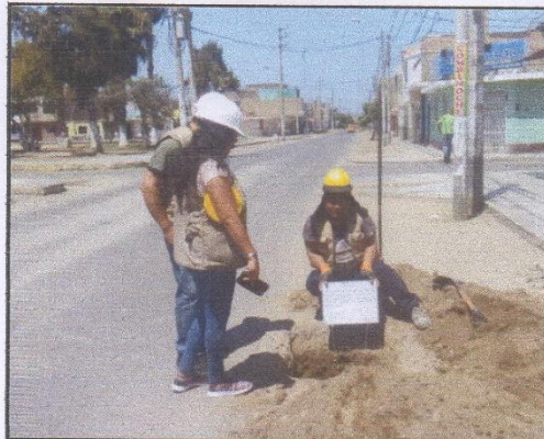
FOTOS 04: SE OBSERVA UNA VISTA PANORÁMICA DE LA EXCAVACION DE LA CALICATA C-02.
