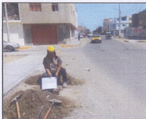
FOTOS 08: SE OBSERVA UNA VISTA PANORÁMICA DE LA EXCAVACION DE LA CALICATA C-04.
