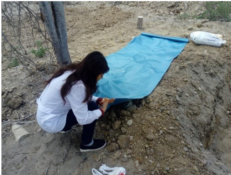
Foto 18: plástico para impermeabilidad del tratamiento de lodos residuales con cal viva.
