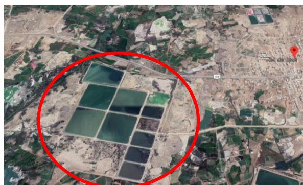
Foto 2 ubicación de las lagunas de oxidación del distrito de San José.
