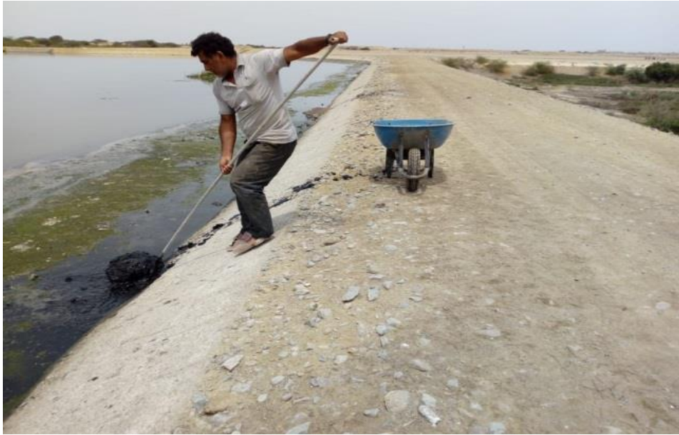
Foto 21: extracción del lodo residual de la laguna de tratamiento primario.
