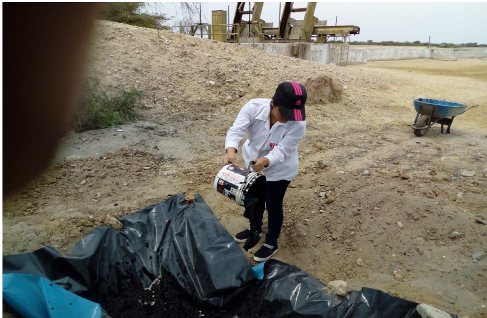
Foto 24: agregar lodo residual en la fosa.
