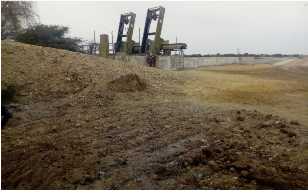
Foto 12: limpieza de terreno en las lagunas de oxidación del Distrito de San José para iniciar el desarrollo de tesis.
