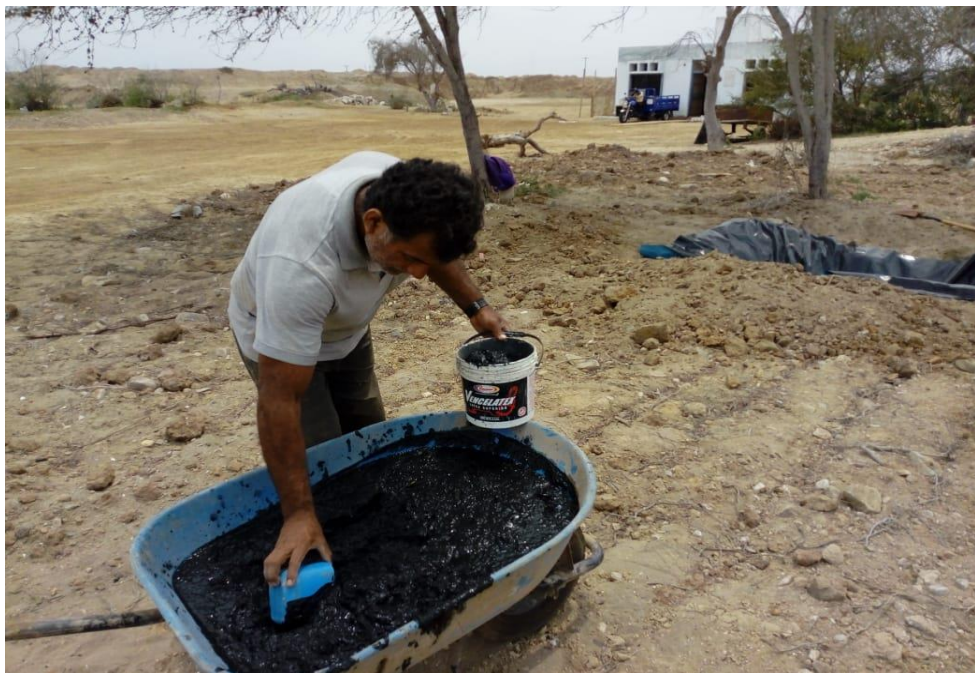
Foto 22: pesado del lodo residual con ayuda del personal de la Empresa EPSEL S.A.
