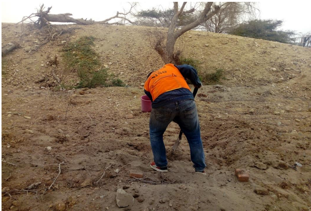
Foto 15: excavación de la fosa con ayuda del personal de EPSEL S.A.
