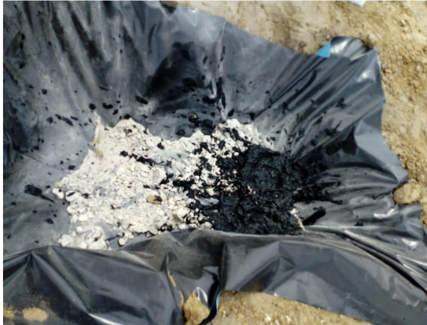
Foto 25: acondicionamiento de la cal viva con el lodo residual.
