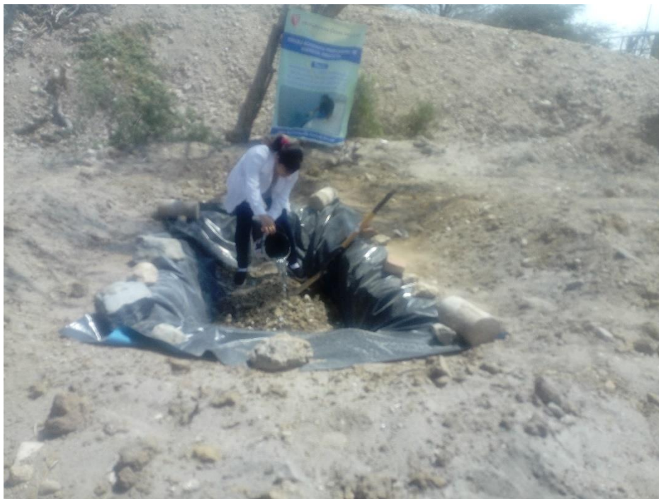
Foto 28: se revuelve la mezcla de cal viva con lodo agregándole agua.
