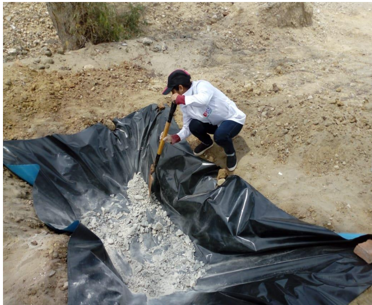
Foto 20: acondicionamiento de la cal viva.
