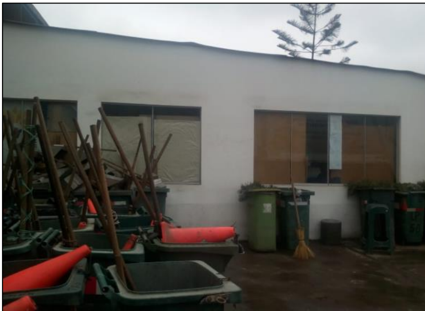
Ilustración 73. Fotografía 3 – Vista desde el interior.
