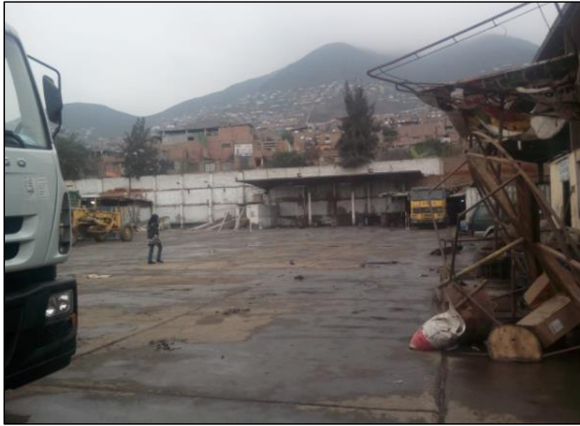
Ilustración 72. Fotografía 2 – Vista desde el interior.
