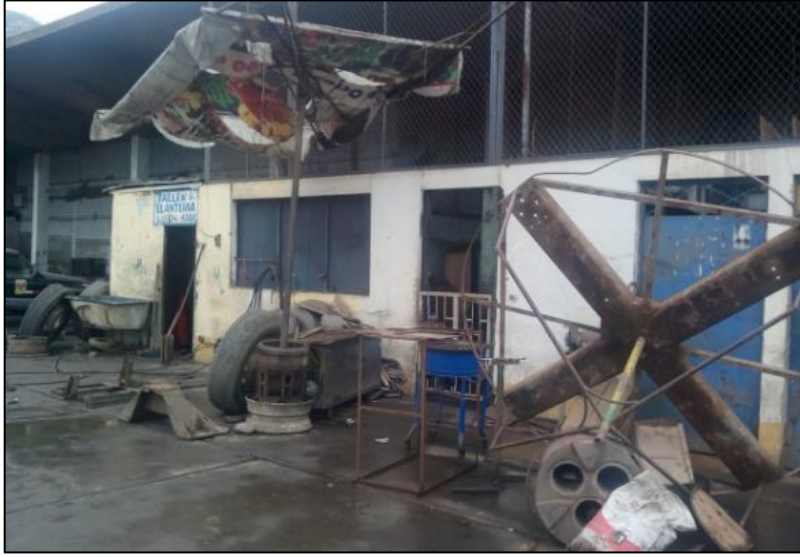
Ilustración 74. Fotografía 4 – Vista desde el interior.
