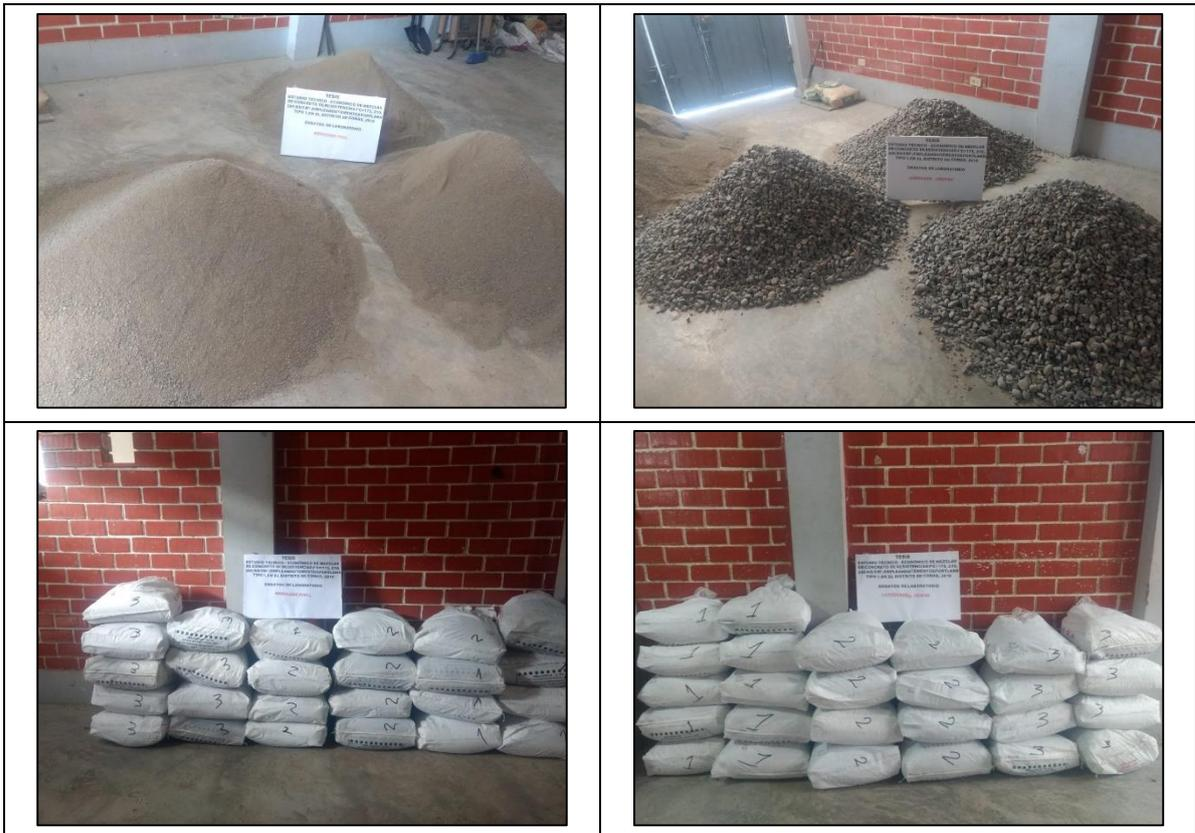
*Figura N° 19: Almacenamiento de agregado fino y grueso*
