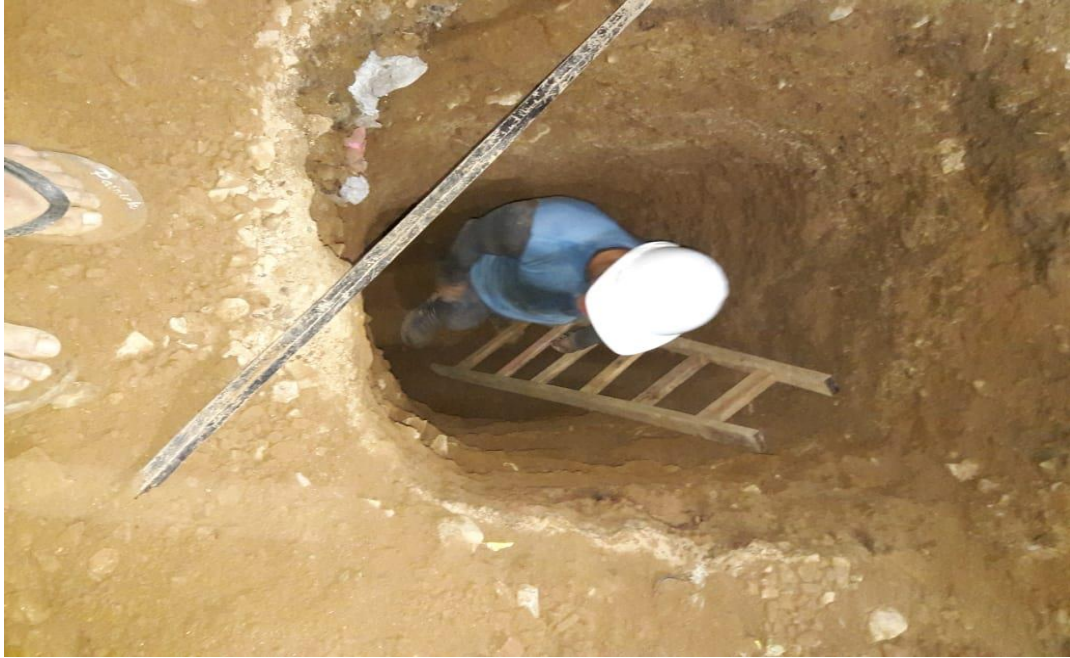
Figura 18: excavación de la calicata de 1m2*3m de profundidad
