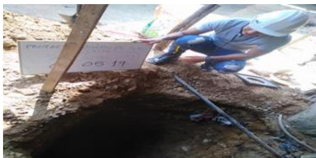
Figura 13: calicata en la zona Fuente: (elaboración propia)
