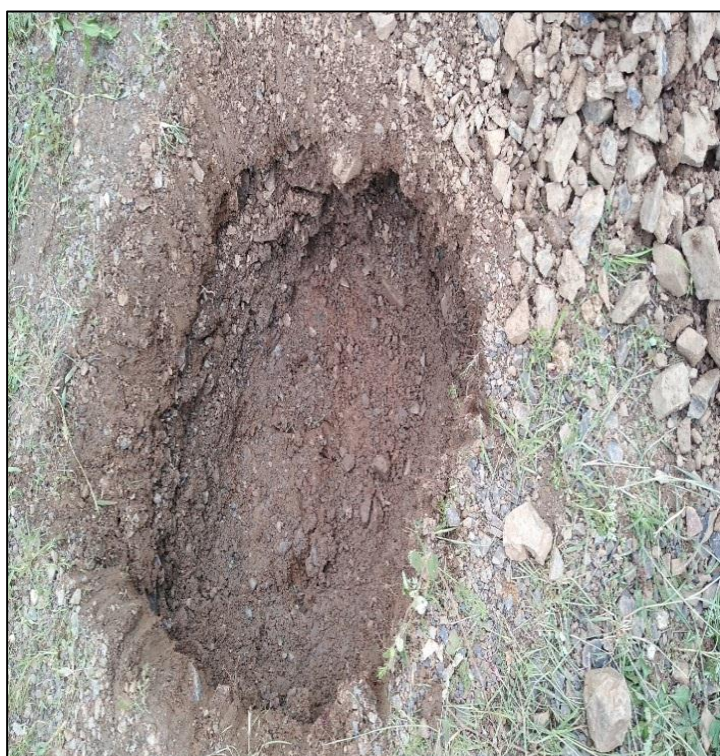
FOTO 13: SE OBSERVA LA EXCAVACIÓN CALICATA C-04.
