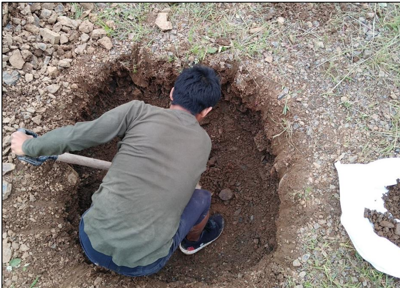
FOTO 15: SE OBSERVA LA EXCAVACIÓN CALICATA C-05.
