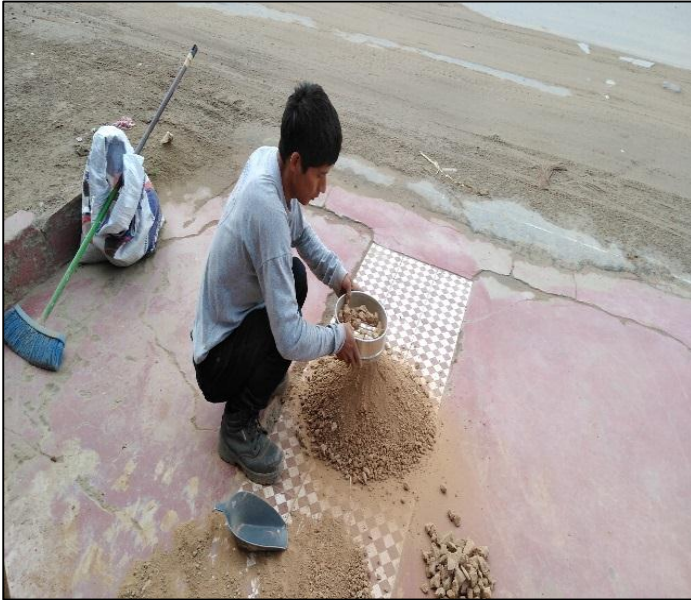
FOTO 23: SE OBSERVA QUE SE REALIZA EL TAMIZADO POR LA MALLA 3/4
