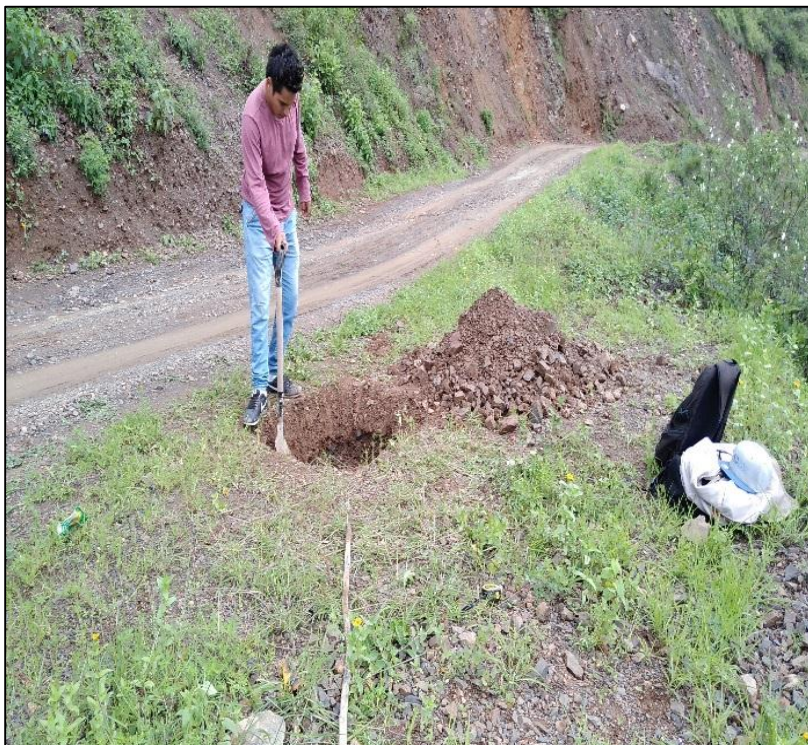
FOTO 11: SE OBSERVA LA EXCAVACIÓN CALICATA C-03.
