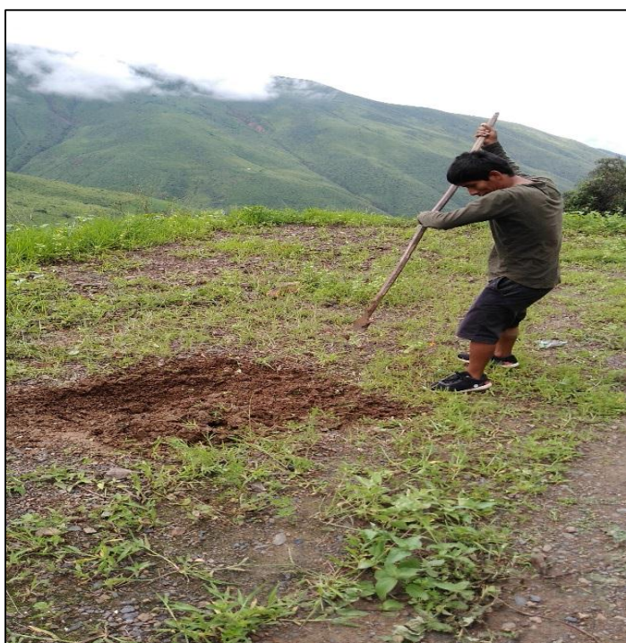
FOTO 12: SE OBSERVA UNA VISTA PANORÁMICA DE LA EXCAVACION DE LA CALICATA. C-04
