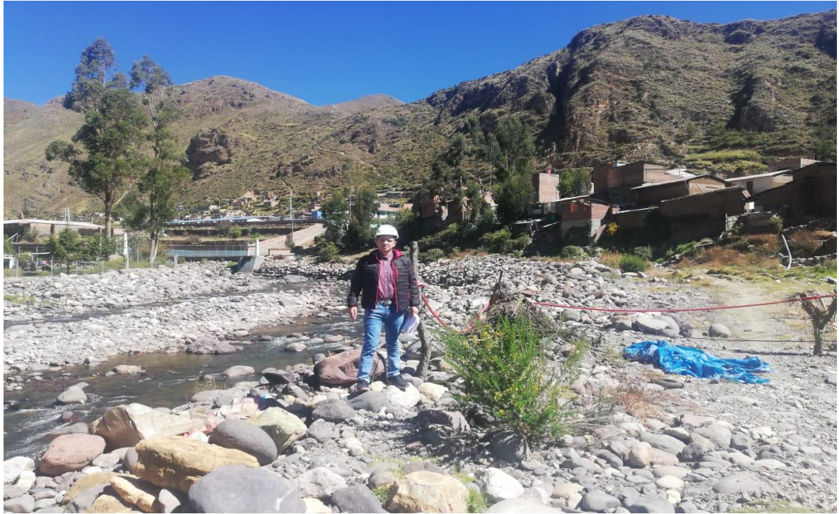
Fotografía 05: Viviendas aledañas al río Sicra, expuestas a inundaciones y derrumbes.
