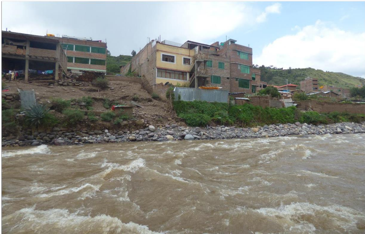
Fotografía 03: Progresiva 5 + 027, expuesta a Socavación producto del flujo erosionable.
