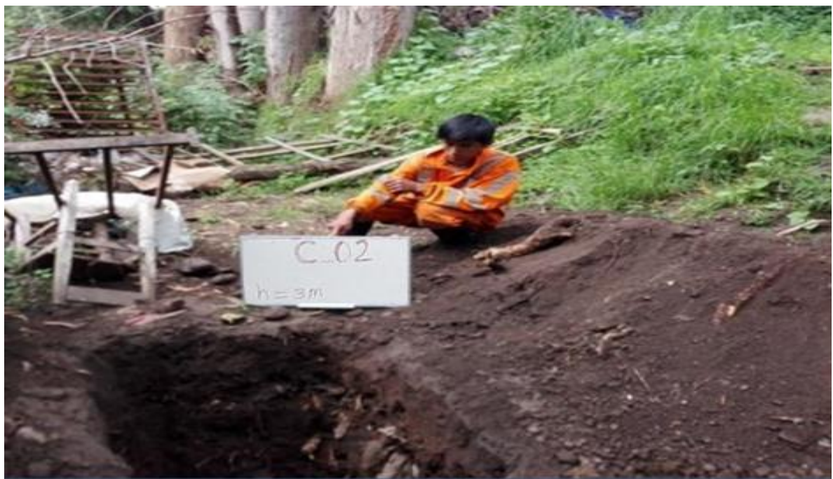
Fotografía 02: Extracción de muestra, calicata N° 02, progresiva 5 + 290, profundidad 3 m.
