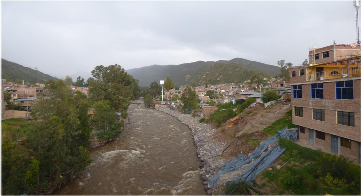
Figura 1. Zona expuesta a inundación, socavación y deslizamiento del río Sicra.
